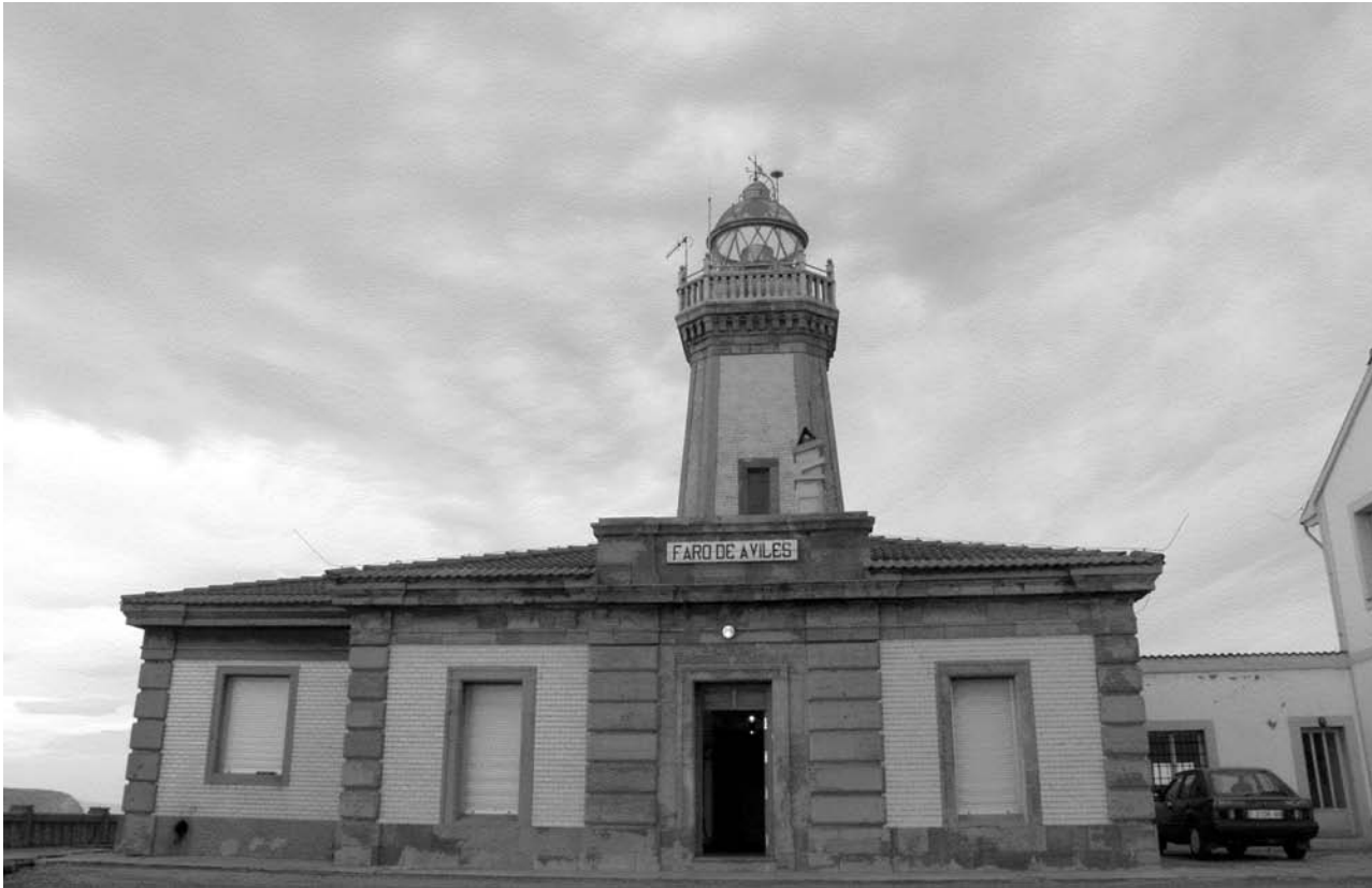
Ejemplo de rehabilitación del faro de Avilés Example of the Avilés lighthouse refurbishing
