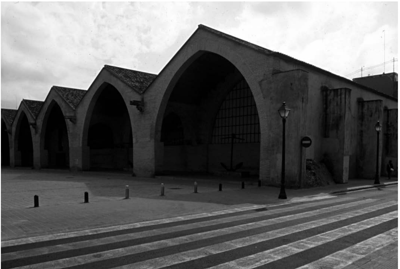
Vista del edificio de las Drassanes del Grau de Valencia.
