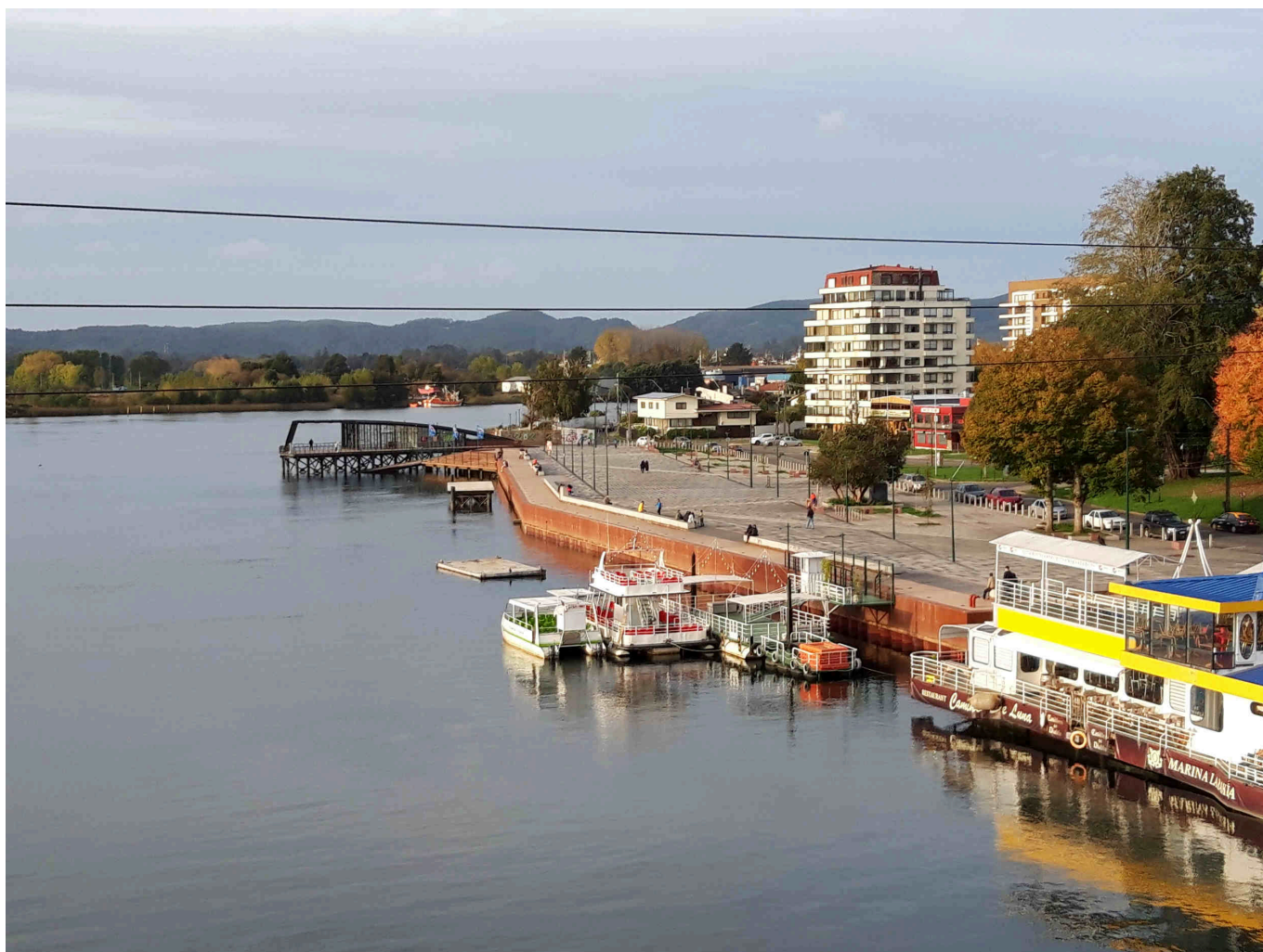
Renovación de sector Helipuerto, parte de los 4 kilómetros de renovación del paseo costanera. (Fuente: Roberto Burgos Mann).
