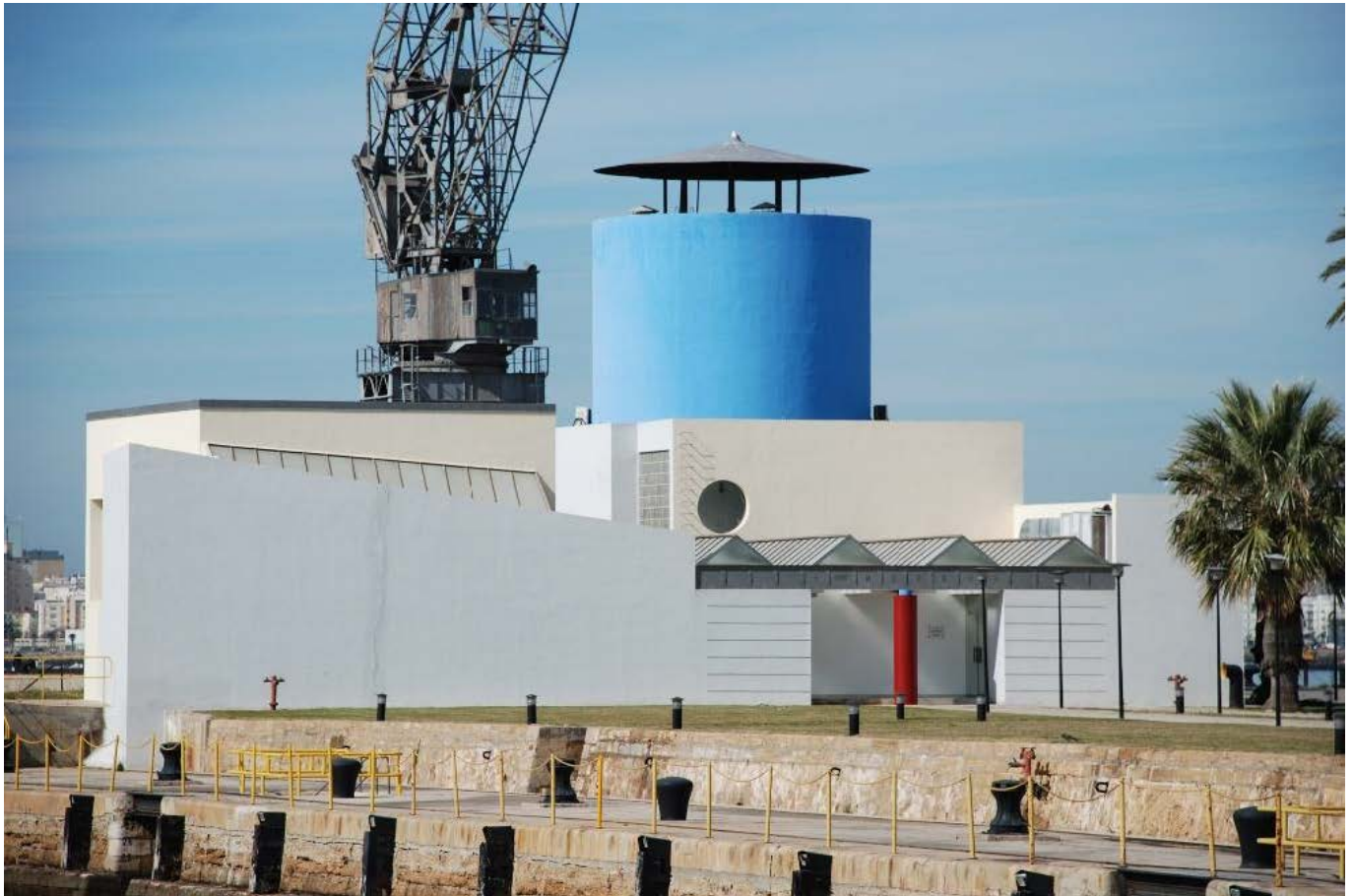
Museo “El Dique”, fachada principal.
