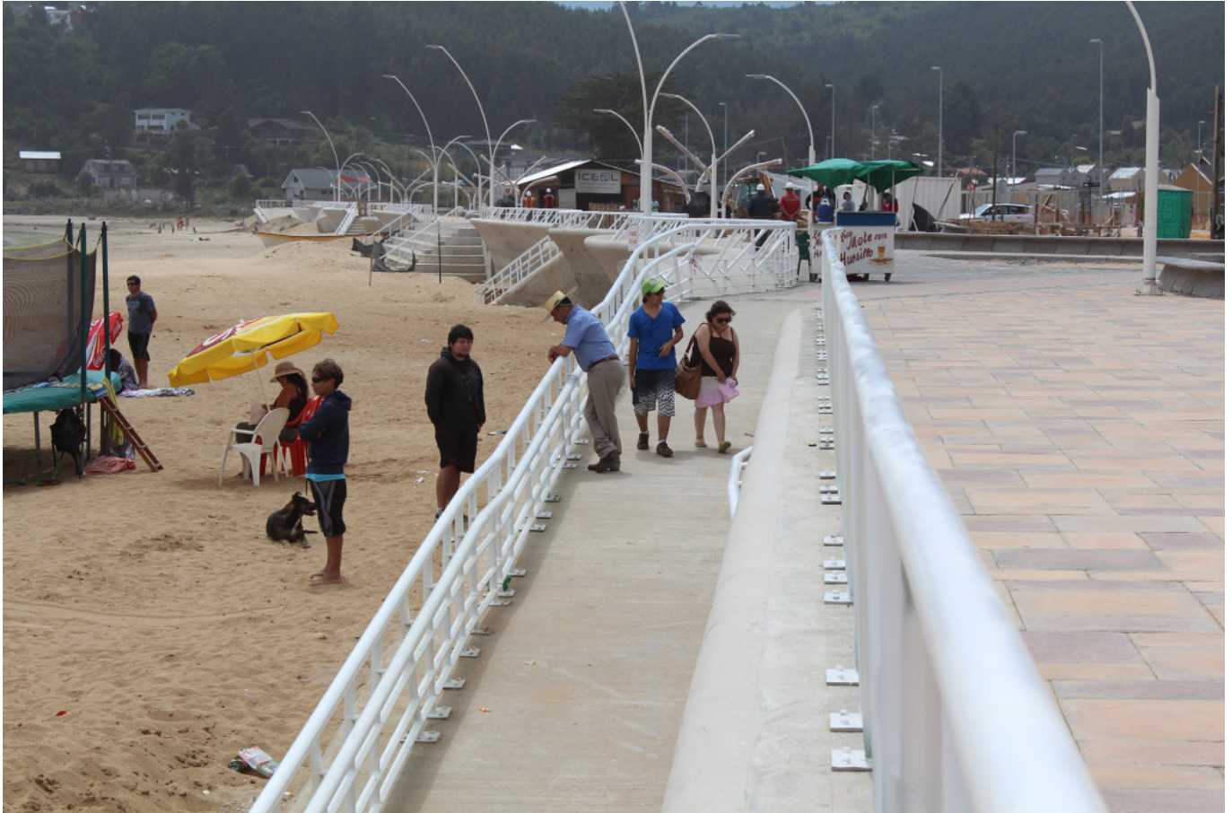
Reconstrucción Borde Costero de Dichato, Región de Bio Bío.
