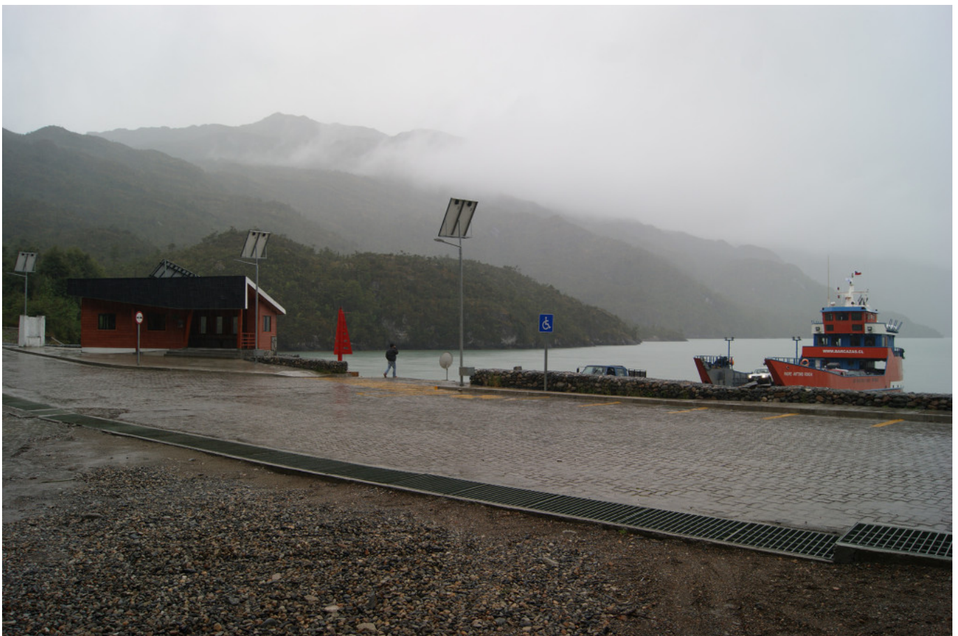
Rampa y refugio de conectividad, Puerto Yungay, Región de Aysen.
