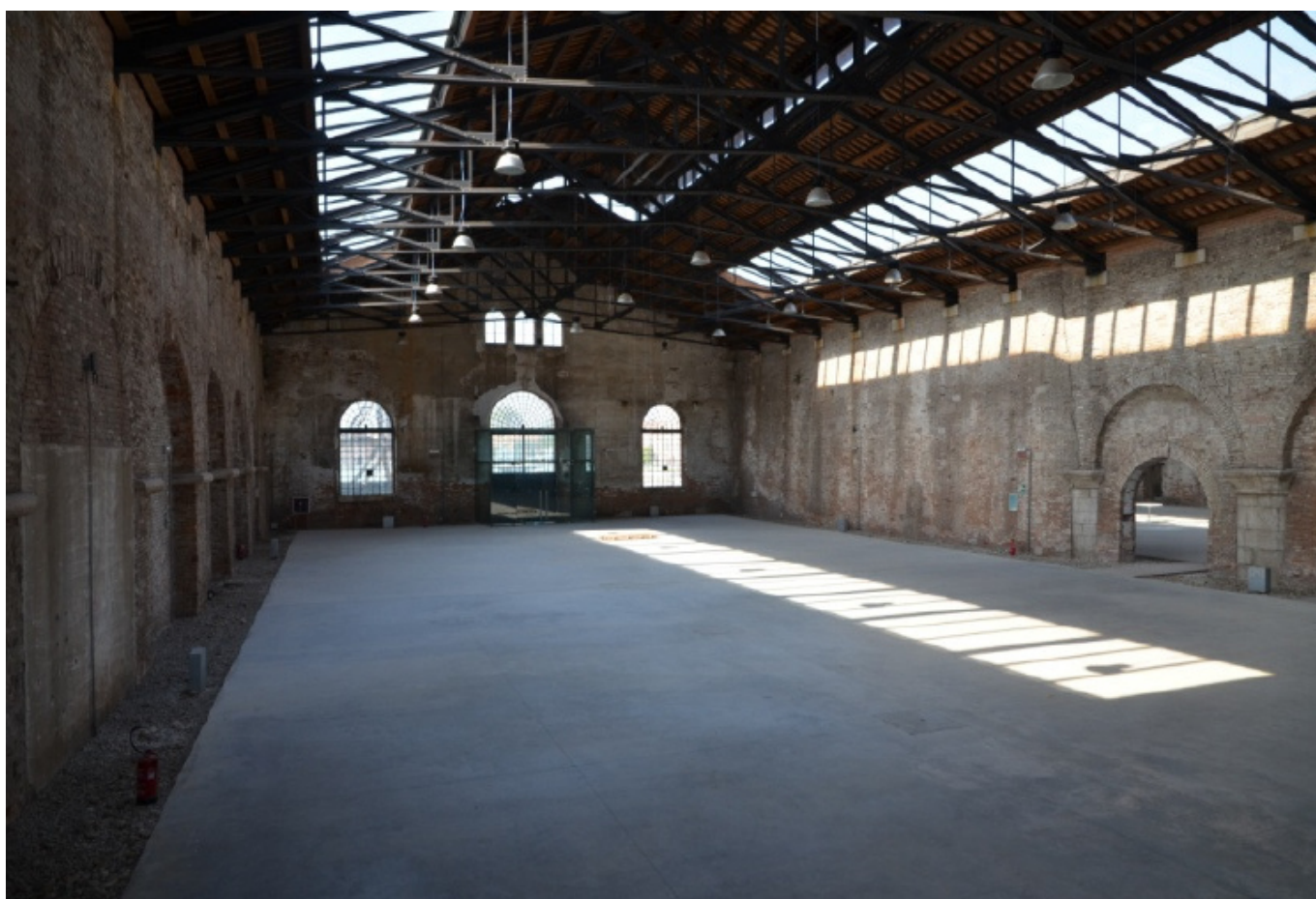
Tese di San Cristoforo after (Tese nn. 92/93/94), project: Thetis s.p.a. and Arsenale di Venezia s.p.a. (2004/2008) - Tesa 110 before - Tesa 102 (now Auditorium CNR). Copyright: Arch. Claudio
