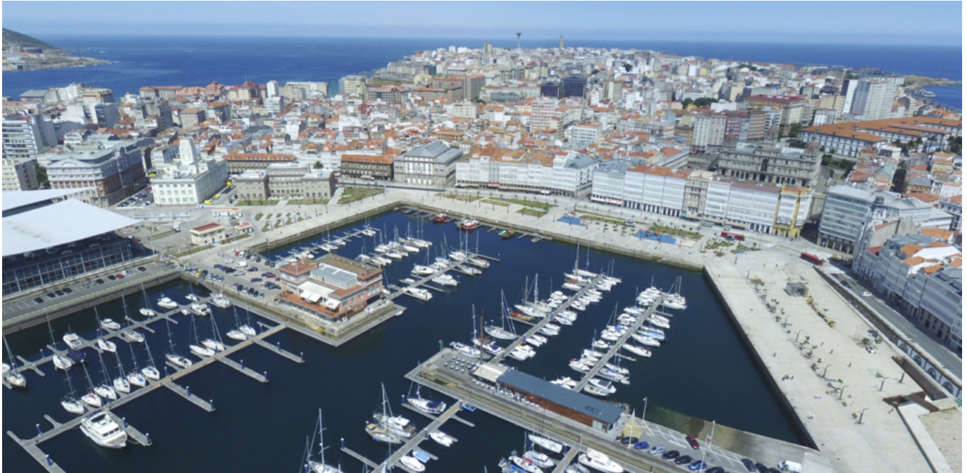
Panorámica de la dársena de la Marina y explanada del Parrote (2017).
