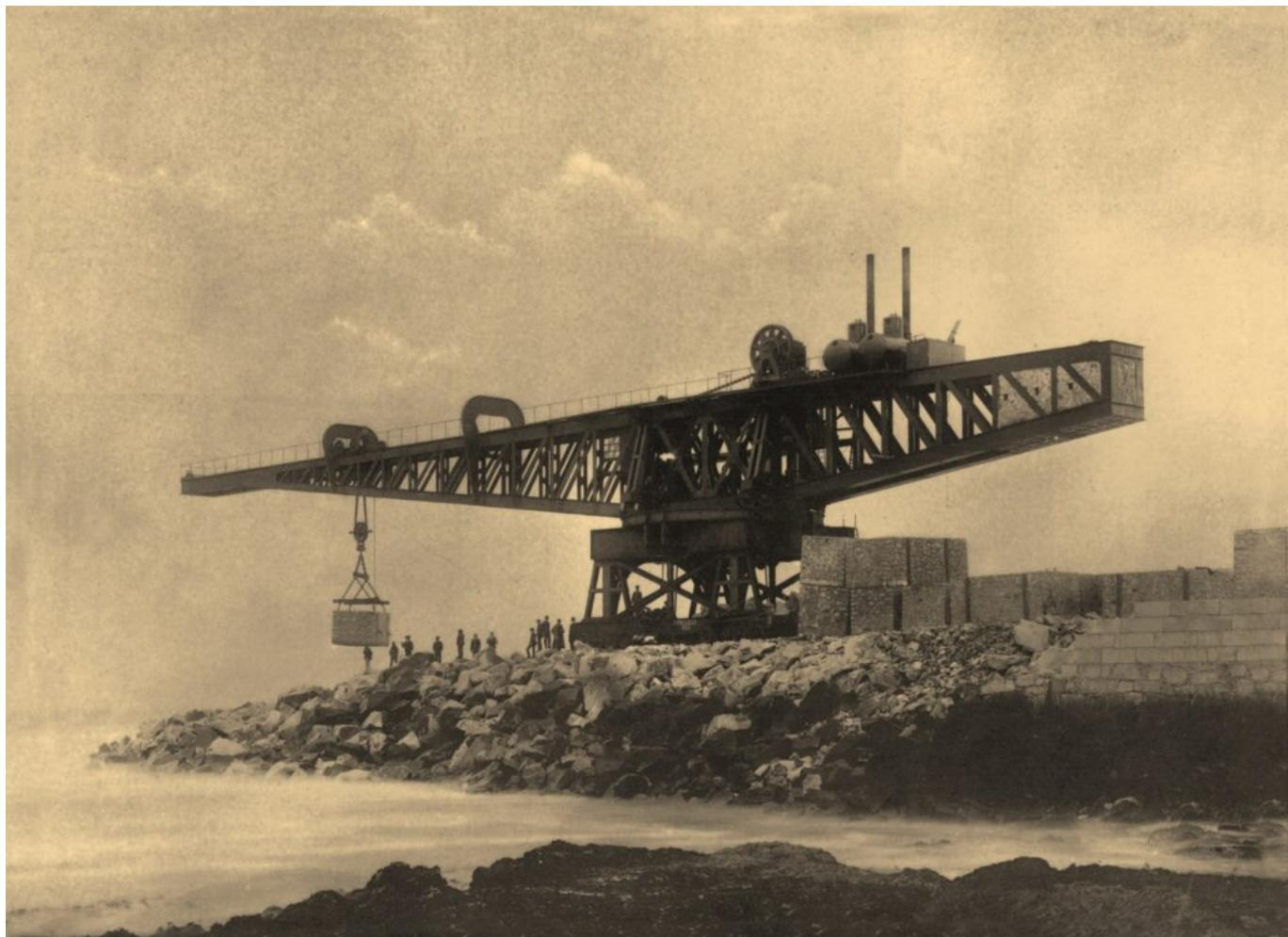
*Após a edificação dos molhes, os Titans continuaram a ser utilizados nas reparações dos paredões, na sequência de danos provocados pela ação tempestuosa do mar. (© Emílio Biel; Fuente: APDL; finais do séc. XX).*
