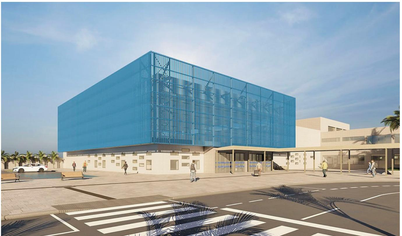
Su configuración estructural replica la retícula modular del edificio existente adaptándose a necesidades provocadas por grandes afluencias de viajeros y espacios amplios y diáfanos. El edificio se configura sobre un zócalo de placas cerámicas que hace que se integre con la terminal existente. Sobre el basamento sobresale un volumen a modo de linterna e hito
