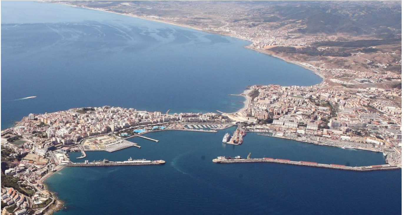
Instalaciones portuarias. (© Autoridad Portuaria de Ceuta).
