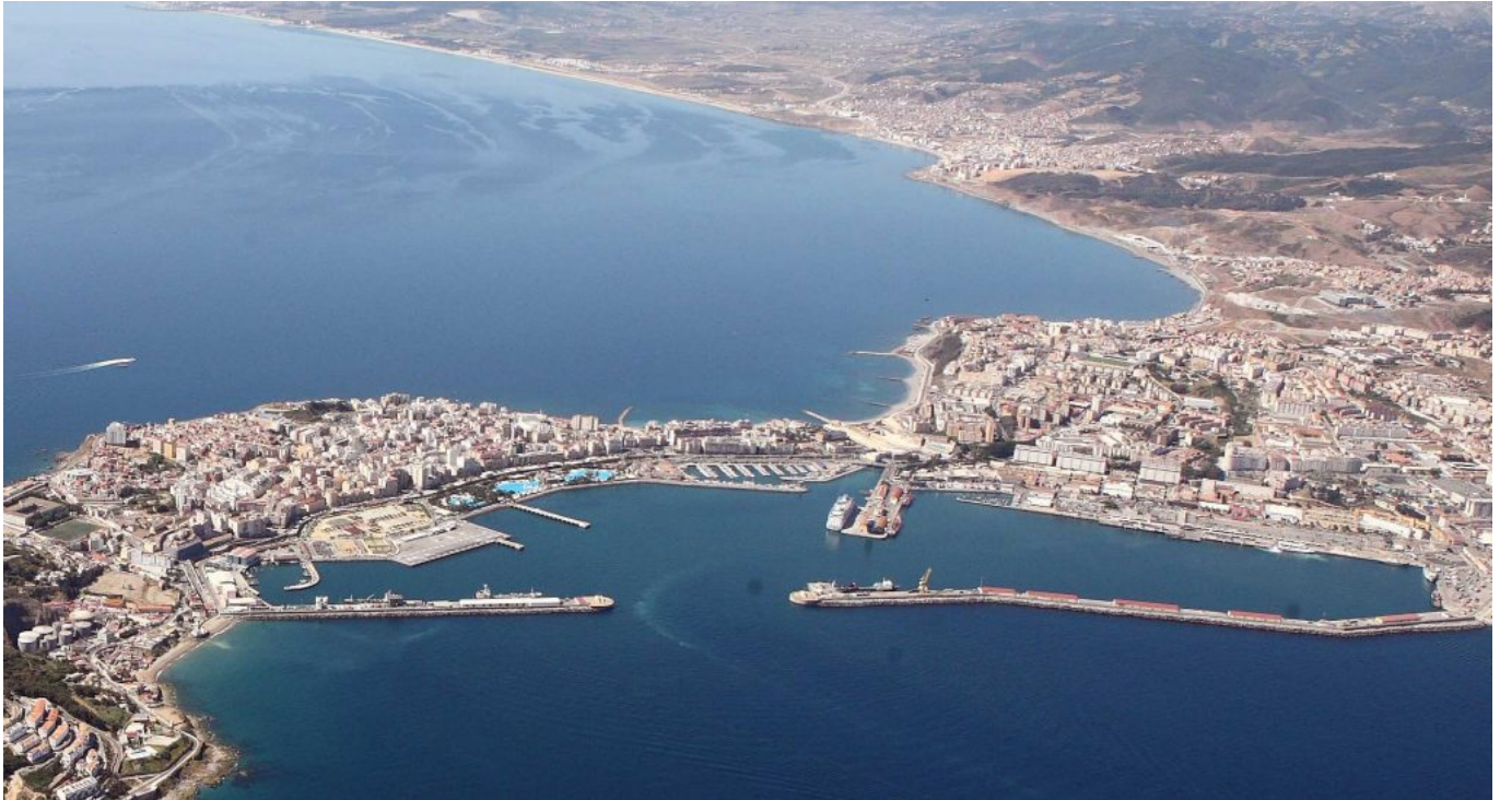
Instalaciones portuarias. (© Autoridad Portuaria de Ceuta).
