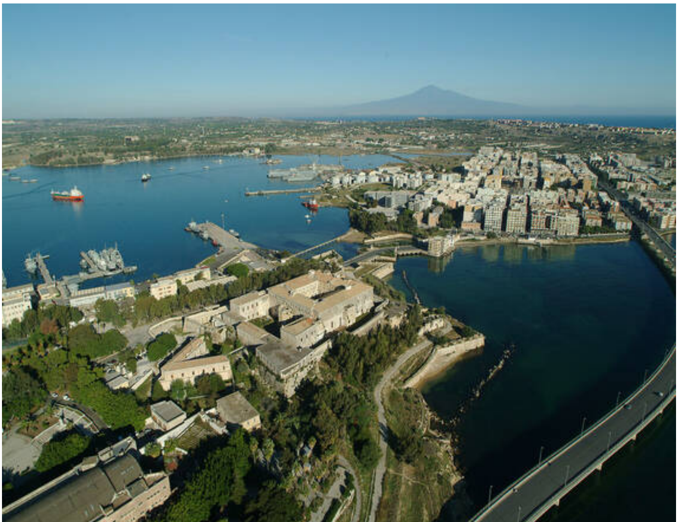
Veduta della Baia di Augusta. (Fonte: Autorità di Sistema Portuale del Mare di Sicilia Orientale).
