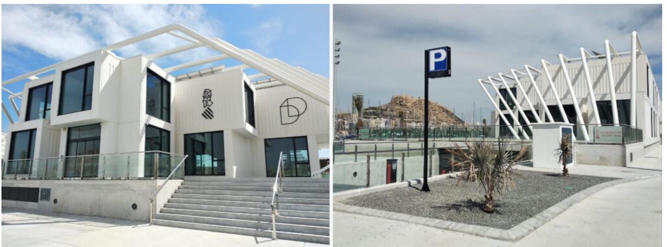
Edificios y espacios abiertos del Distrito Digital de la Comunidad Valenciana. (Fuente:
