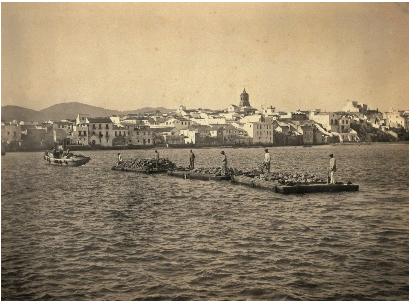
Barcazas de obras en la construcción del muelle de La Galera, 1917. (Fuente: Archivo fotográfico de la Autoridad Portuaria de la Bahía de Algeciras).
