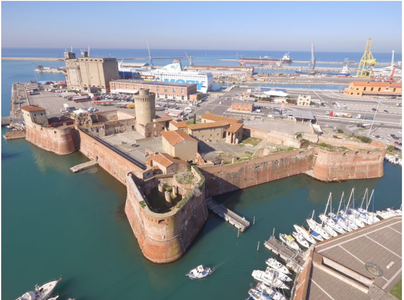
Veduta della Fortezza Vecchia di Livorno. (Fonte: Porto Immobiliare S.r.l.).
