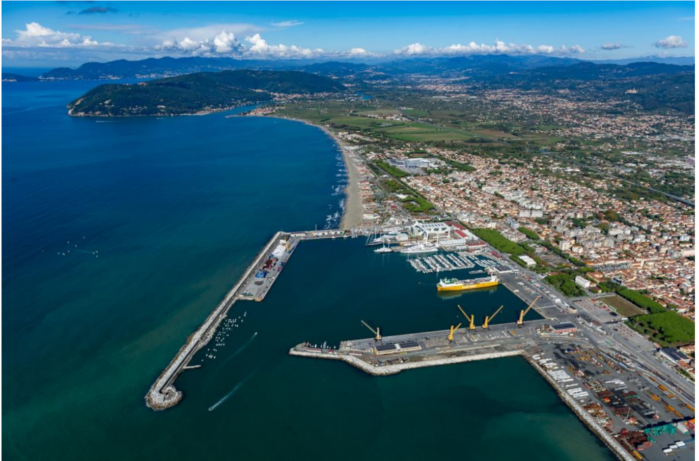
Veduta panoramica della città di Marina di Carrara, dell'area portuale e del waterfront. (Fonte: AdSP Mar Ligure Orientale).
