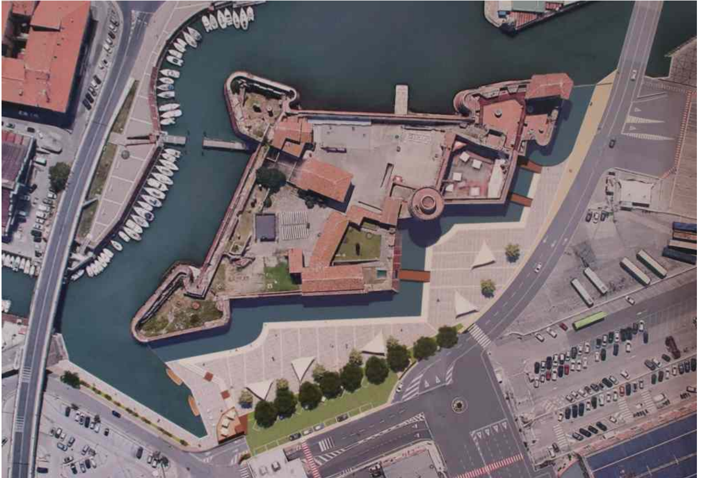
Trasformazione della Fortezza Vecchia nel progetto acquaticità PRP e Parco Fortezza Porto Immobiliare. (Fonte: Porto Immobiliare S.r.l.).
