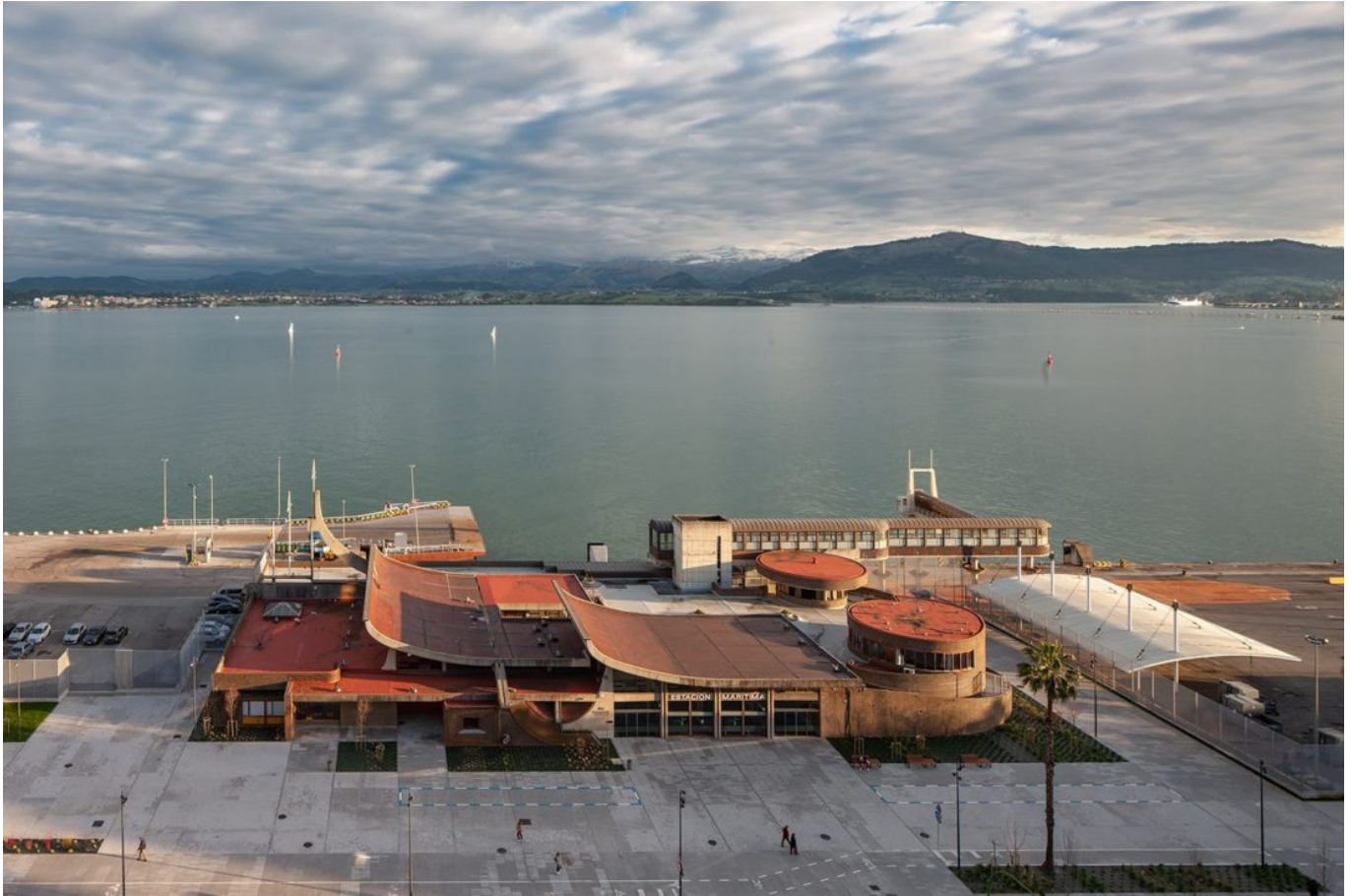
Estación Marítima del Puerto de Santander. (Fuente: Autoridad Portuaria de Santander).
