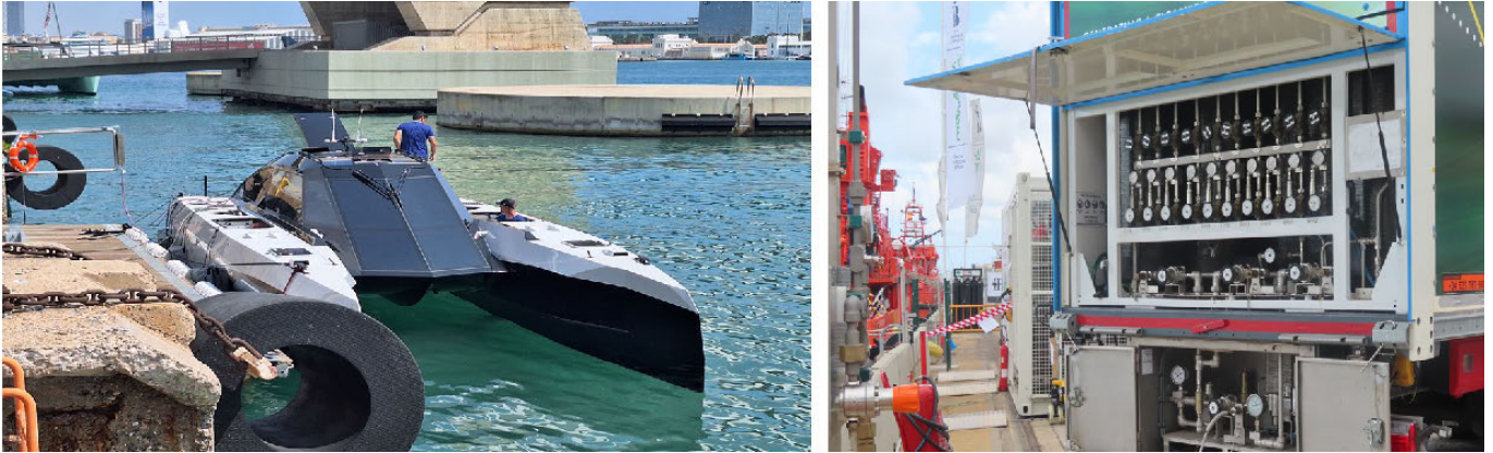
Hidrolinera instalada en el Puerto de Barcelona durante la 37ª Copa América. (© Oficina Copa América Port de Barcelona, 2024).
