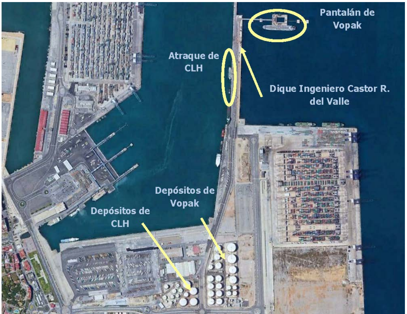
Terminales de Vopak y CLH en el puerto Bahía de Algeciras. (Fuente: J.L. Estrada a partir de Google Earth).
