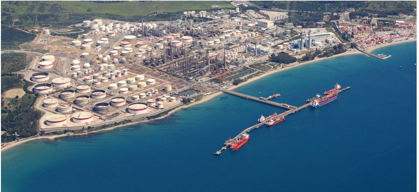
Terminal de Cepsa en el puerto Bahía de Algeciras. (Fuente: Autoridad Portuaria Bahía de Algeciras).
