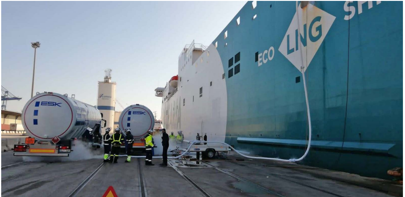
Bunkering de GNL mediante camión cisterna en el puerto de Valencia. (Fuente: Balearia).
