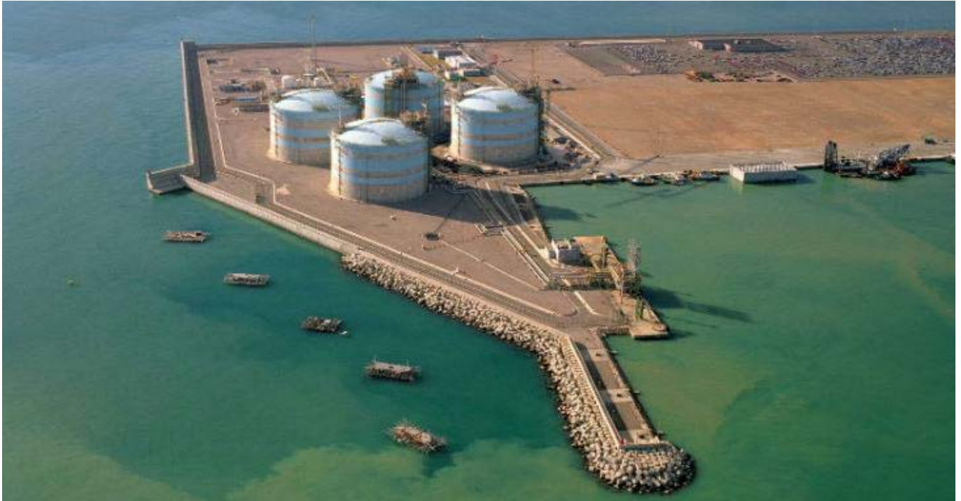
Terminal de Naturgy de GNL en el puerto de Sagunto. (Fuente: Naturgy).
