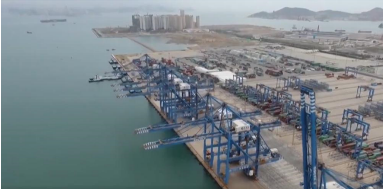
Grúas STS automáticas del Puerto de Qingdao. (Fuente: Port of Qingdao)
