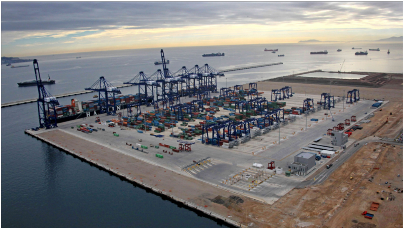
Terminal TTI Algeciras. (Fuente: TTI-A)
