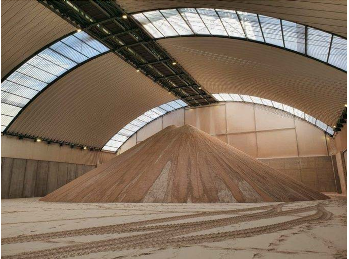
Apilado de potasa en almacén cubierto en la Terminal ICL Iberia. Puerto de Barcelona. (Fuente: ICL Iberia).
