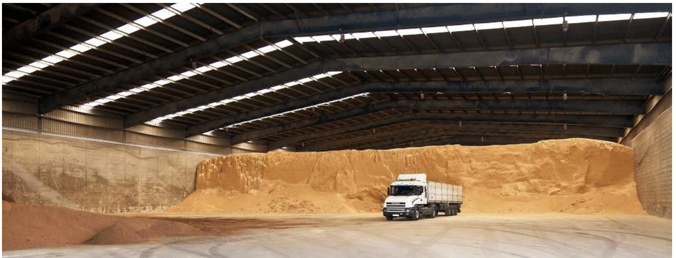
Almacén de graneles agroalimentarios con paredes reforzadas. Puerto de Tarragona. (Fuente: Autoridad Portuaria de Tarragona).
