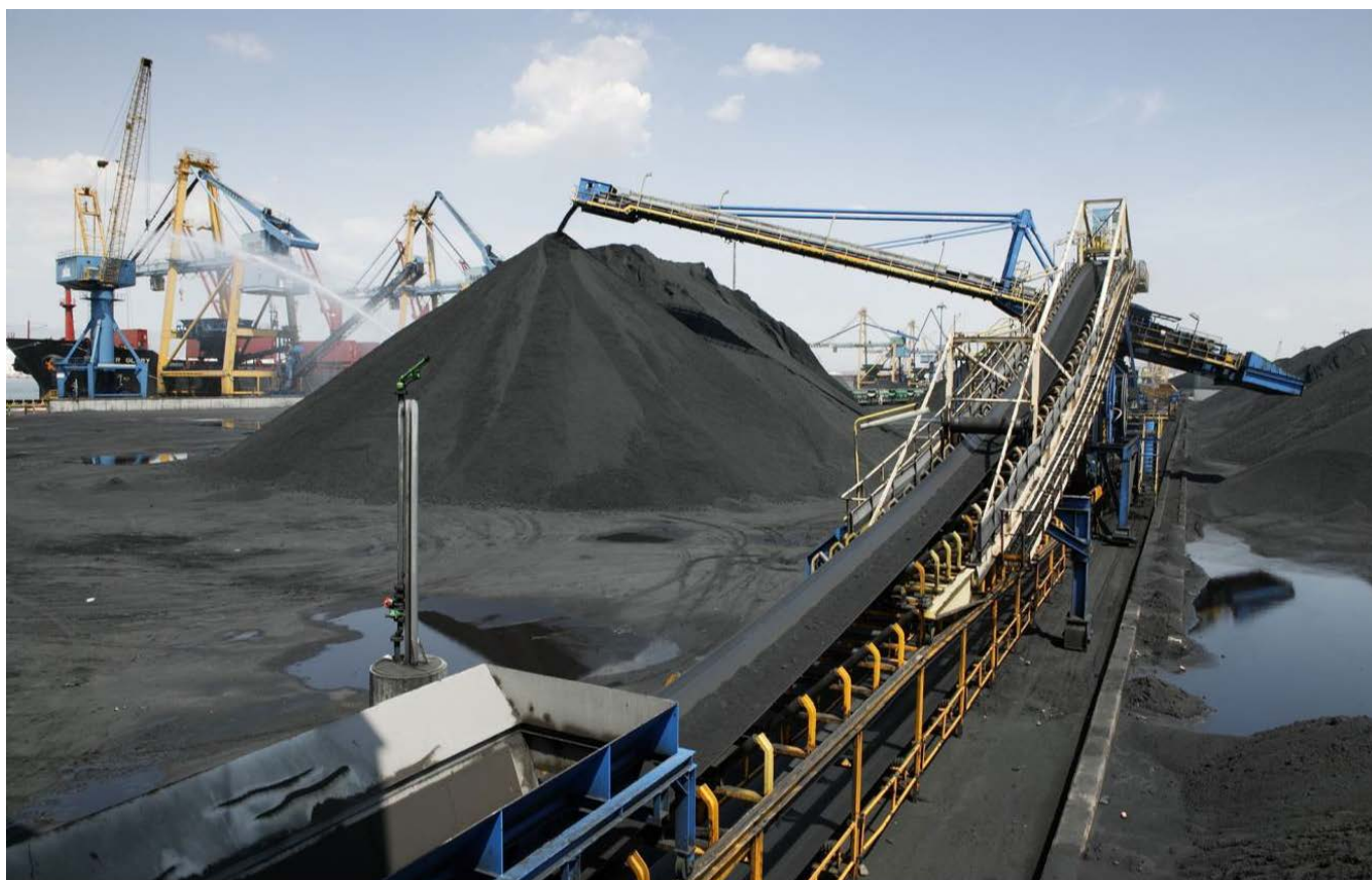
Apilado de carbón mediante apiladora (stacker) en la terminal de Euroports Ibérica TPS. Muelle Cataluña, puerto de Tarragona. (Fuente: Taim Weser).
