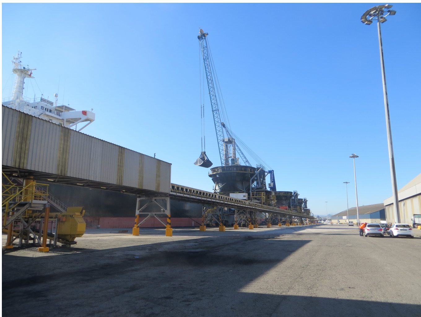
Descarga de carbón en la terminal de Noatum. Descarga con grúa móvil y cuchara sobre tolva ecológica a parque de cintas cerrado. Puerto de Santander. (Fuente: J.L. Estrada).
