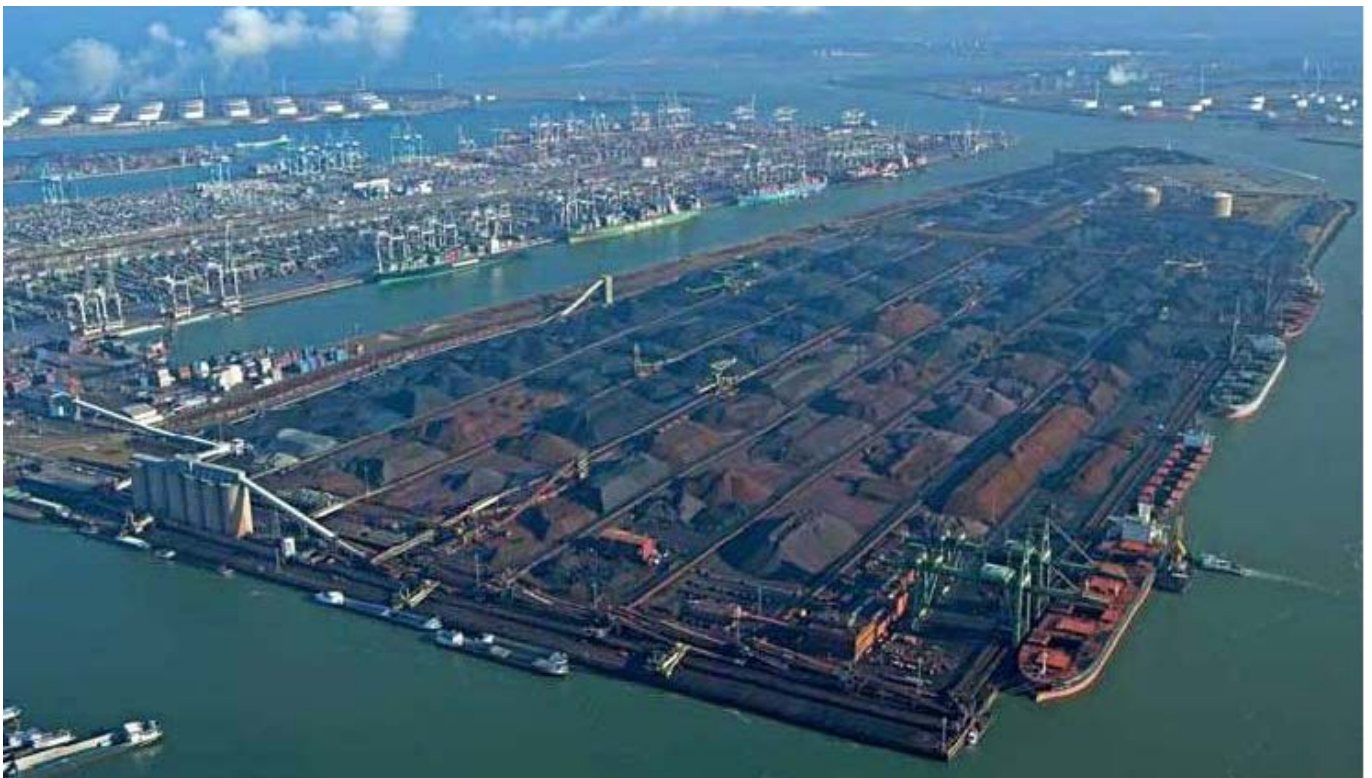
Terminal EMO de carga y descarga de graneles sólidos. Puerto de Rotterdam. (Fuente: Dry Cargo International).
