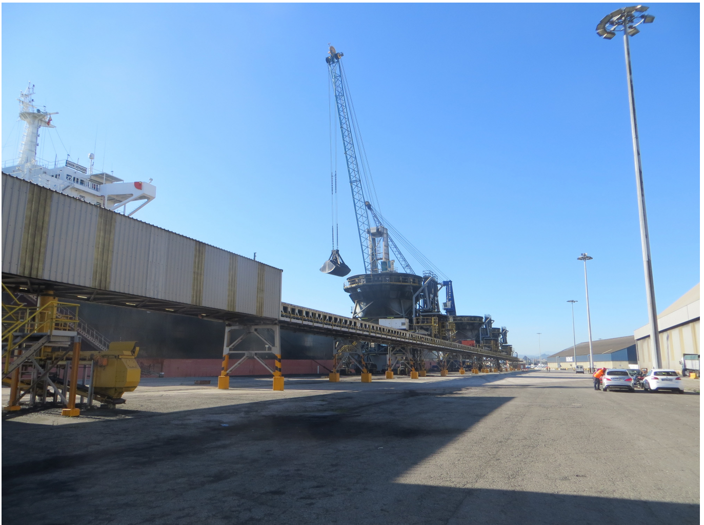
Descarga de carbón en la terminal de Noatum. Descarga con grúa móvil y cuchara sobre tolva ecológica a parque de cintas cerrado. Puerto de Santander. (Fuente: J.L.
