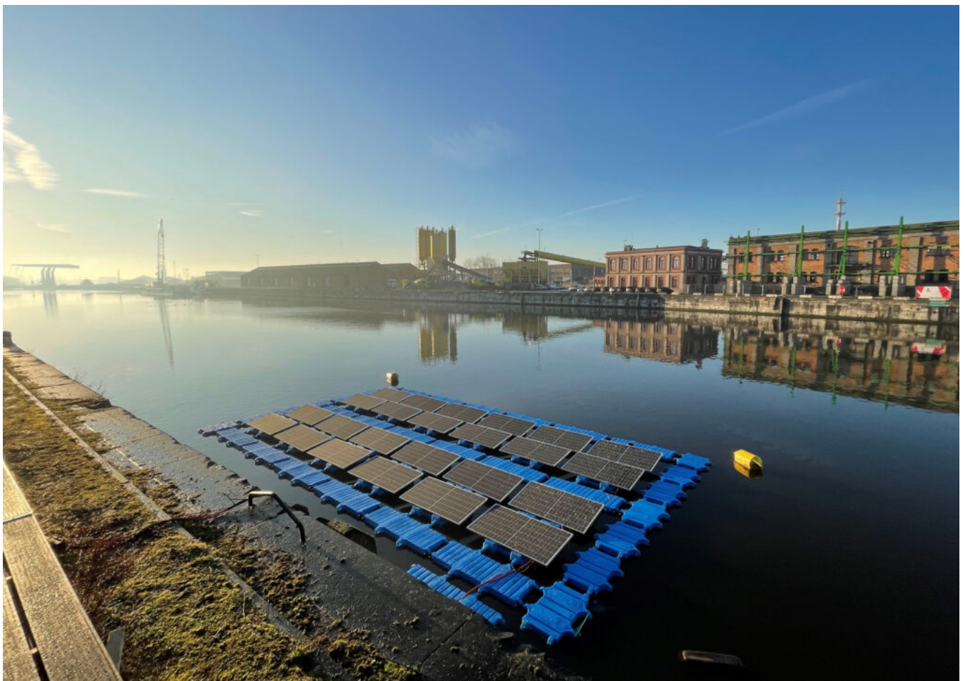
Planta de energía solar flotante en Port Oostende, Bélgica. (Fuente: https://greenpipegroup.com/project/floating-solar-power-plant-in-port-oostende-belgium/ ).
