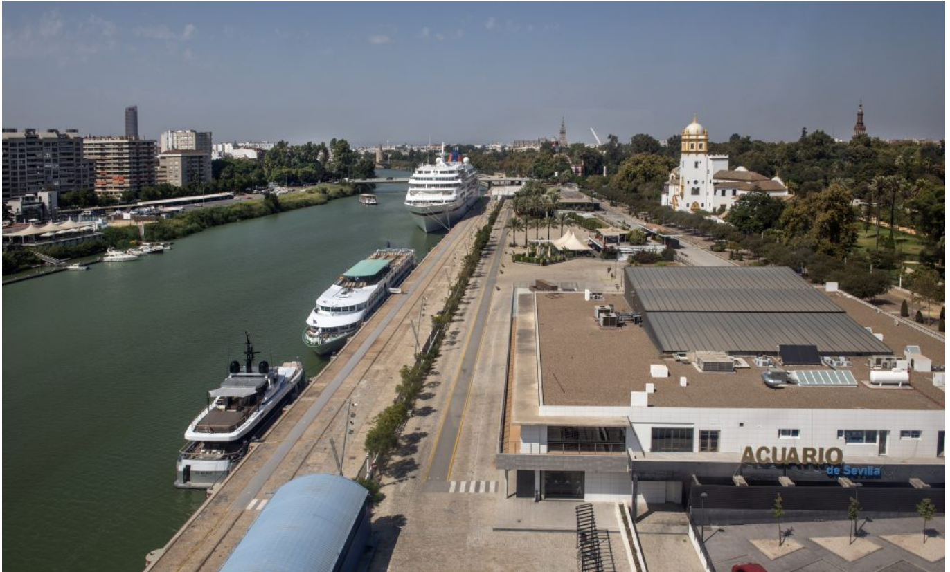
Vista área de Muelle de las Delicias. (© Autoridad Portuaria de Sevilla).
