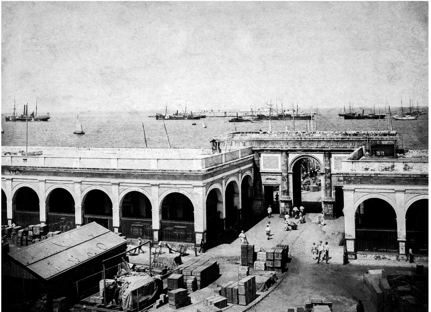
Aduana y Puerta de Mar.
