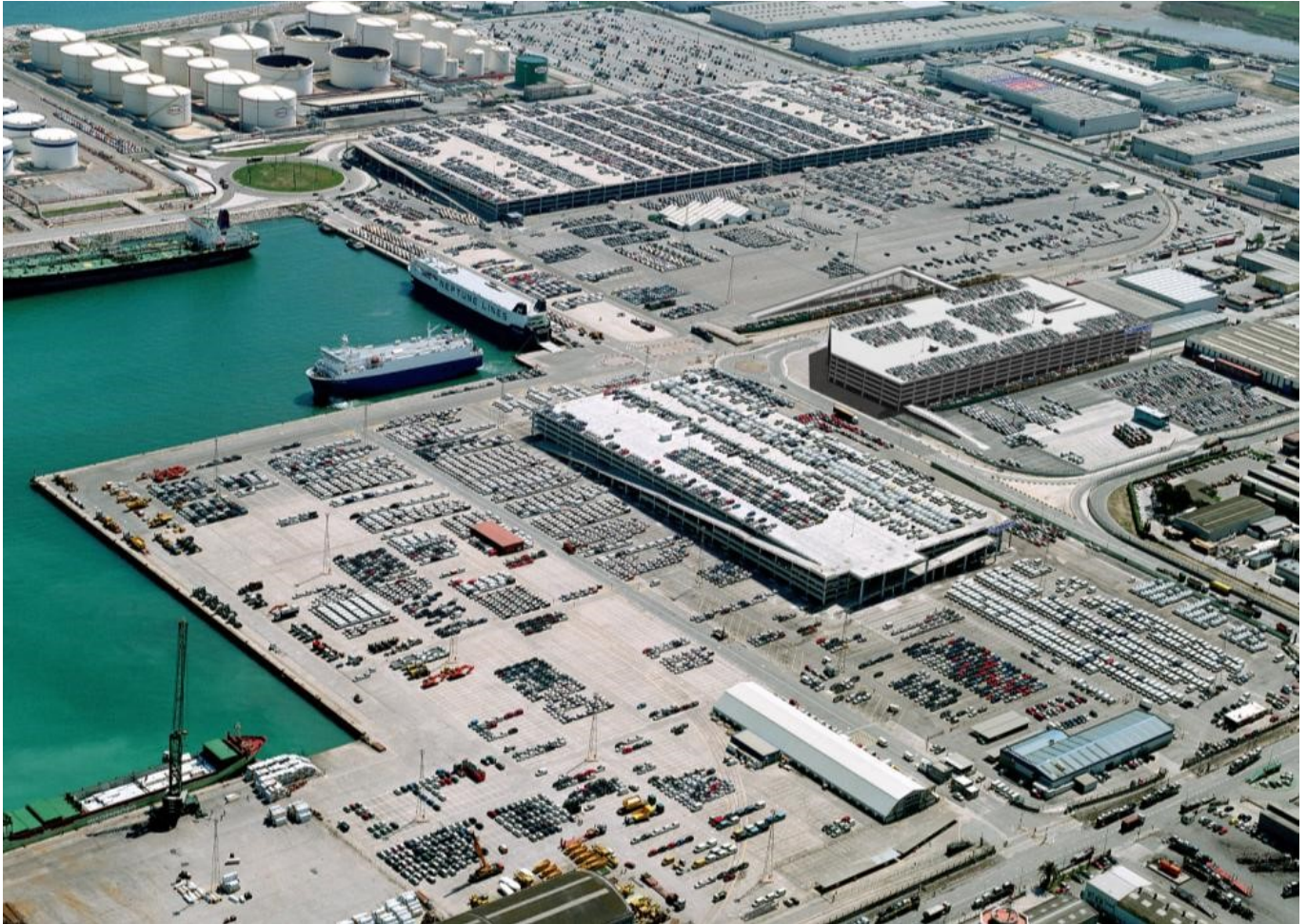
Terminal de vehículos nuevos (Autoterminal y SETRAM) en la dársena Sur del Port de Barcelona, incluyendo los atraques RoRo, explanadas y almacenes o silos verticales de vehículos. (Fuente: SETRAM).
