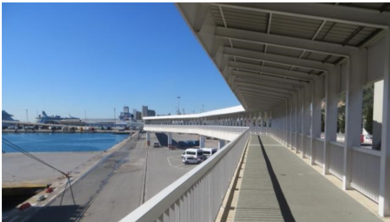
Terminal de ferries de Balearia en el muelle de les Drassanes con sus pasarelas elevadas
