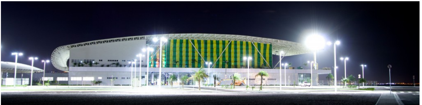
Fortaleza/CE. Terminal de passageiros, parte do projeto de revitalização e requalificação do entorno do Mucuripe.
