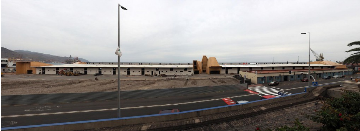
Nueva estación en construcción (febrero de 2016).
