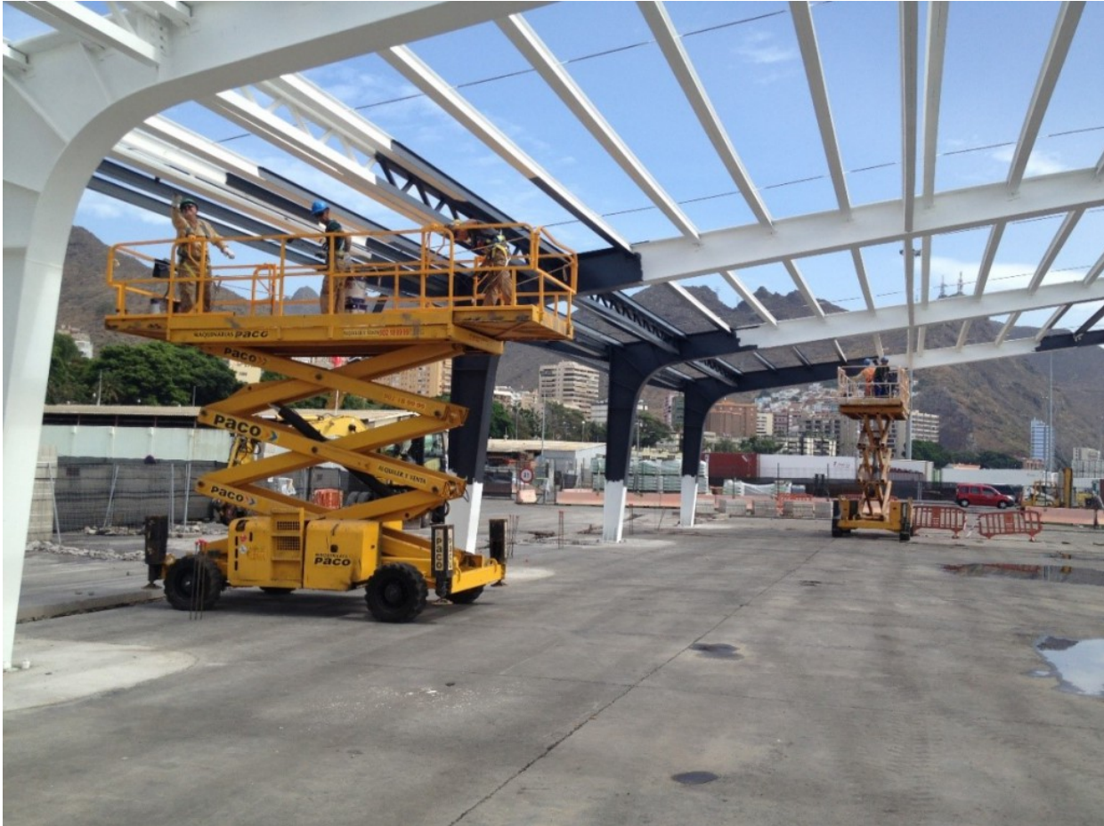
Tratamiento de la estructura de los tinglados.
