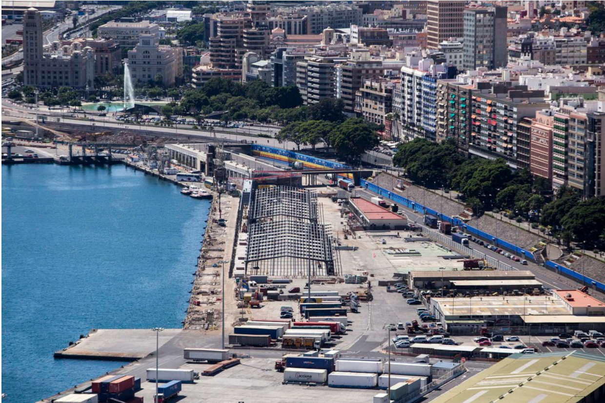
Vista general de las obras en los tinglados, muelle y entorno.
