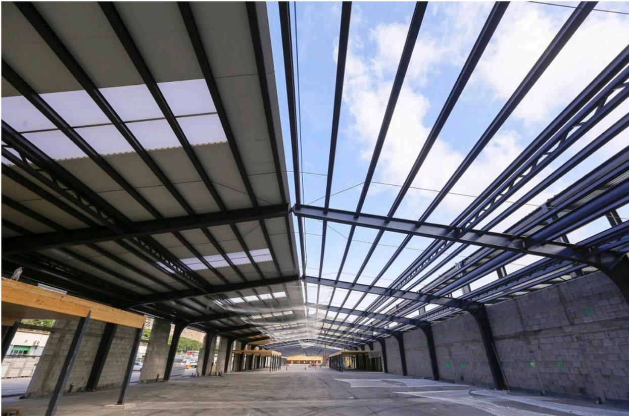
*Cubrición del tinglado con la estructura metálica ya tratada y ejecución de cerramientos.*
