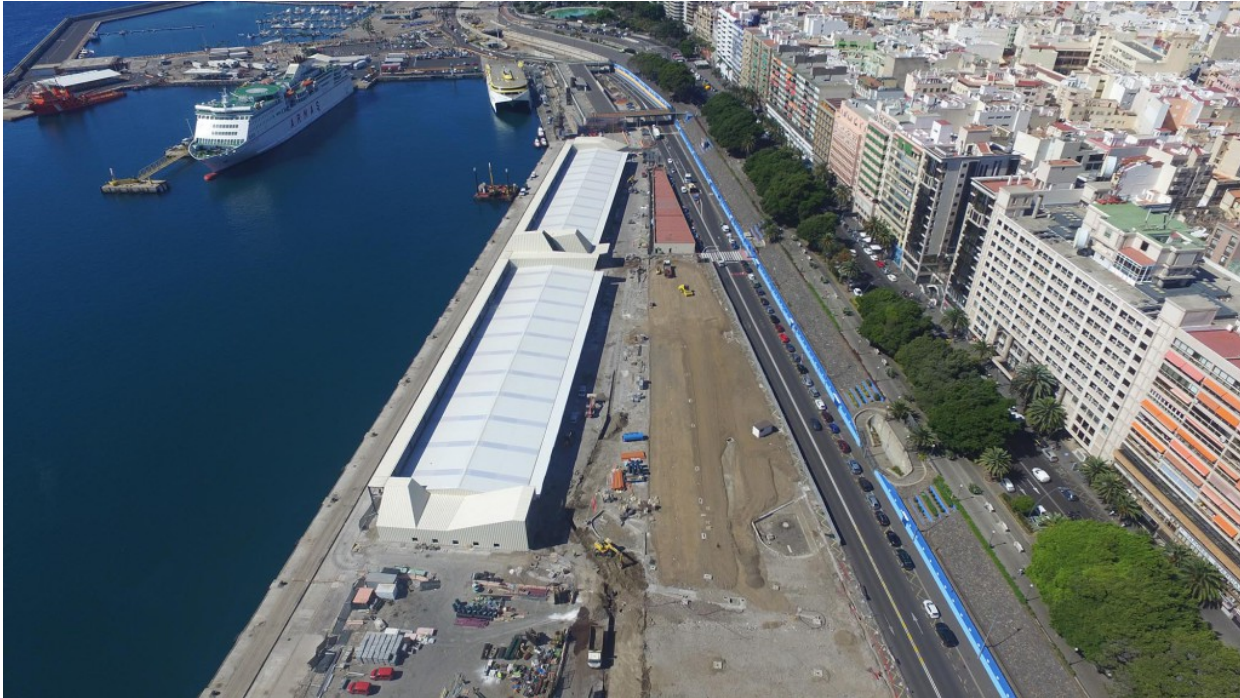
Nueva estación en construcción y urbanización del entorno (mediados 2016).
