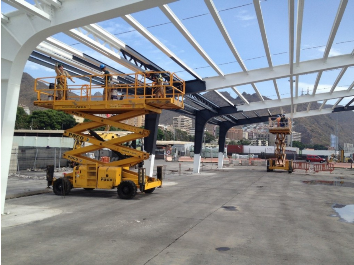
Tratamiento de la estructura de los tinglados.
