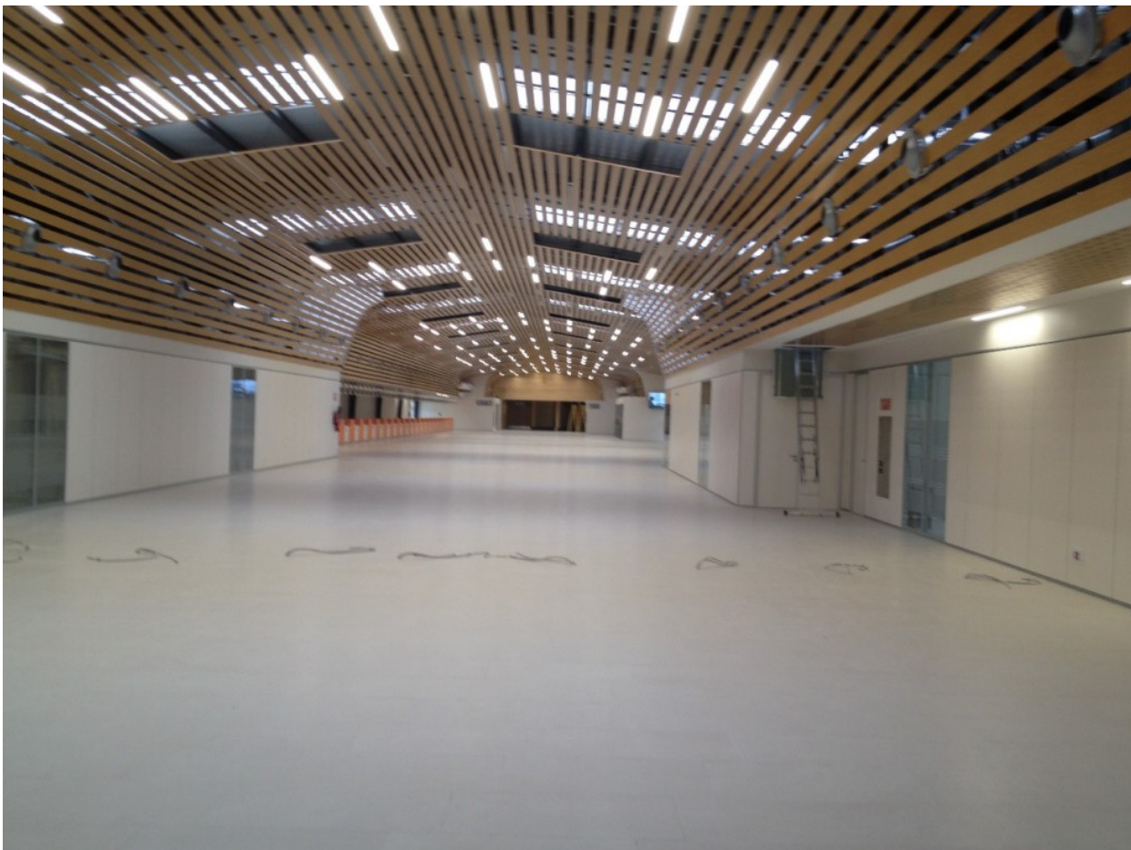
Acabado interior de uno de los tinglados reutilizados para la nueva estación.
