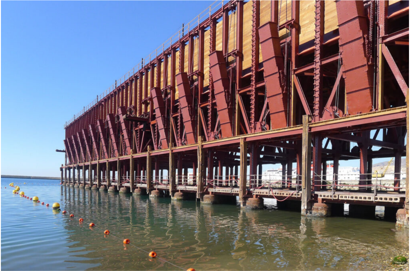
Muelle de carga. (Proyecto de restauración, Ramón de Torres, 2023).
