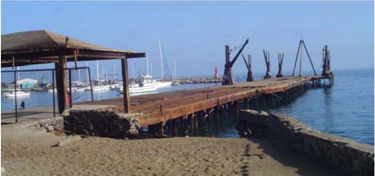
Vista general, estribo y Muelle, 2005. (Fuente: Elaboración propia)
