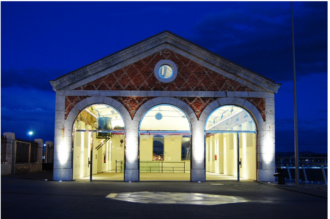
Vista nocturna de la fachada oeste de la casa de bombas. 2014. (R. Suárez)
