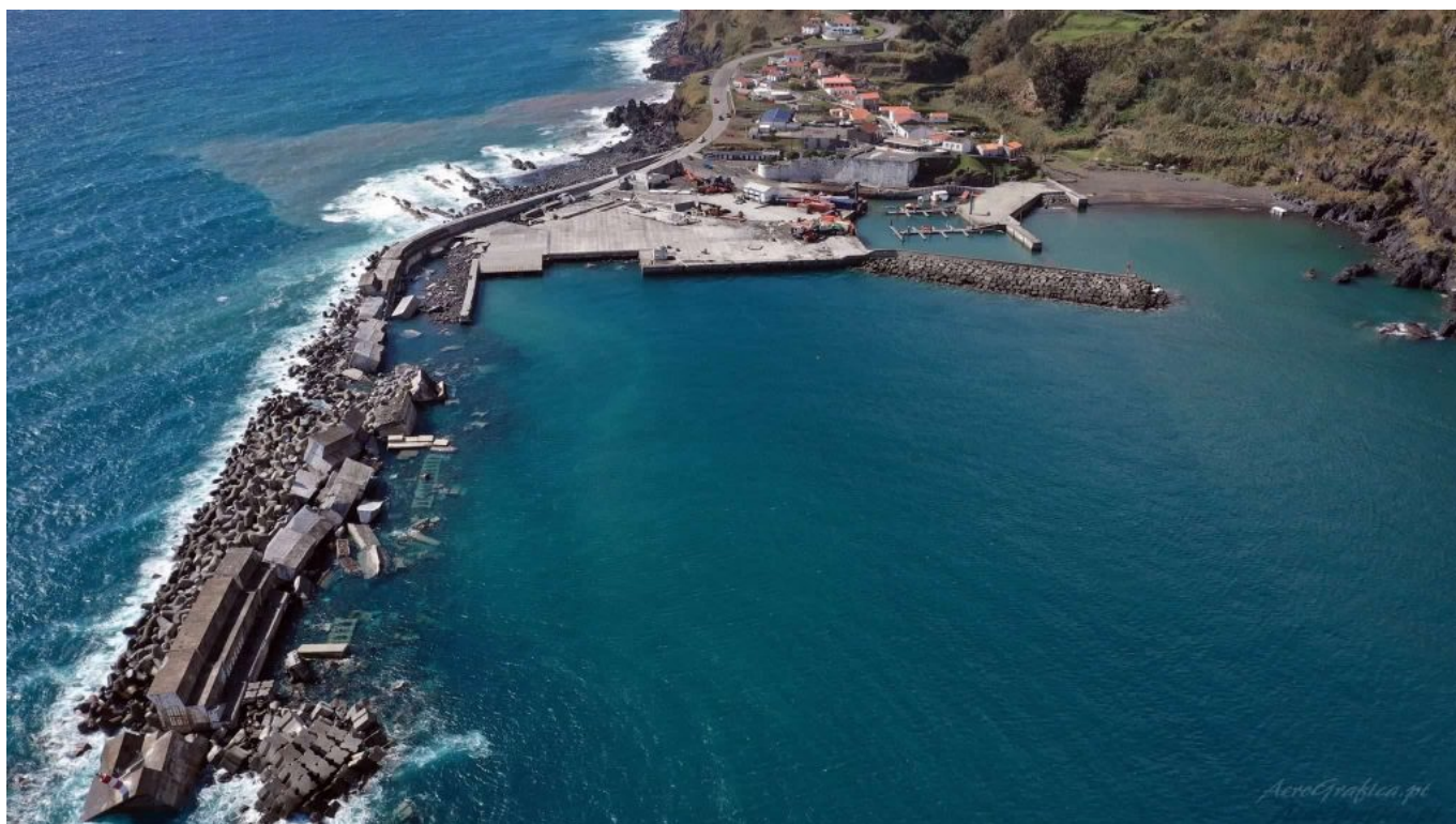
Vista geral do Porto das Lajes da Flores, após a passagem do furacão "Lorenzo". (© Portos dos Açores S.A.).
