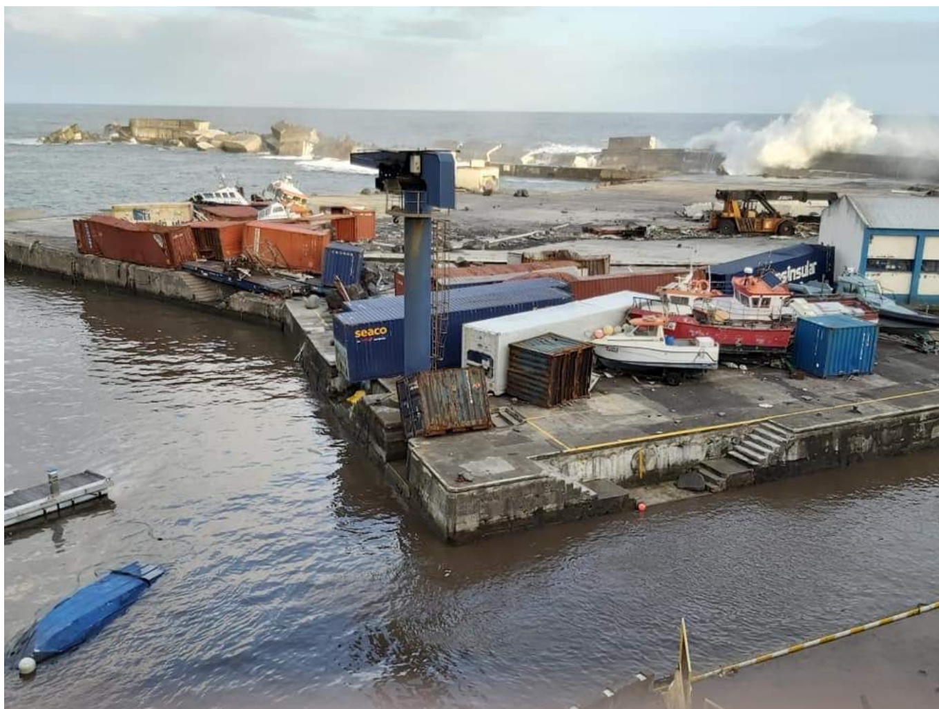
Vista parcial do porto, sendo visível o estado do terrapleno após a passagem do furacão. (© Portos dos Açores S.A.).
