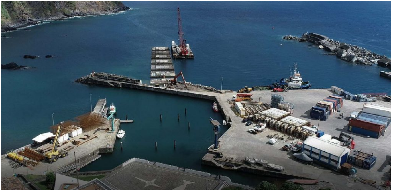
Foto da construção da ponte-cais, em outubro de 2021. (© Portos dos Açores S.A.).
