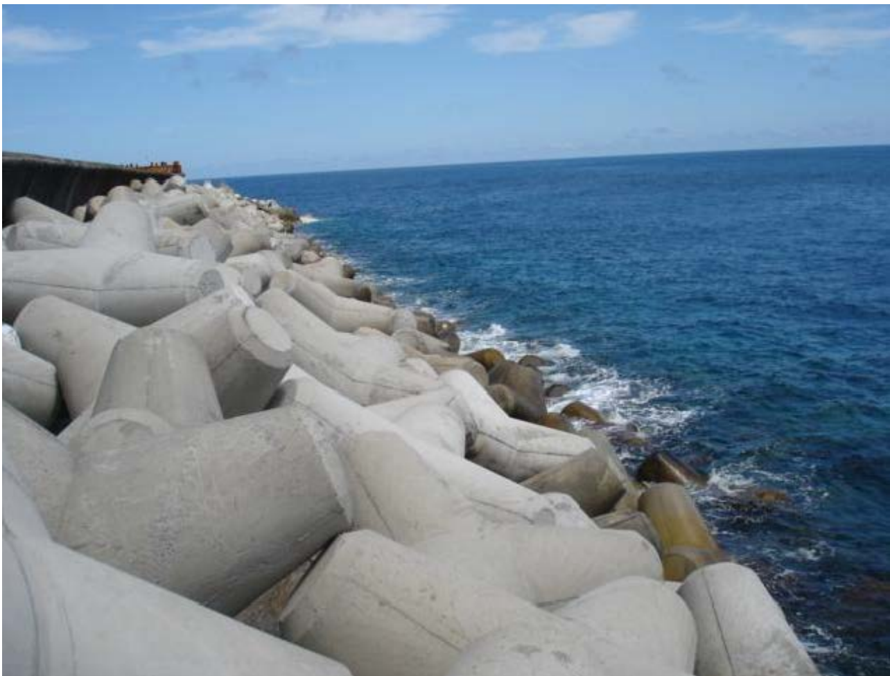
Vista parcial do manto de proteção exterior do molhe, após reparação em 2006. (© Portos dos Açores S.A.).
