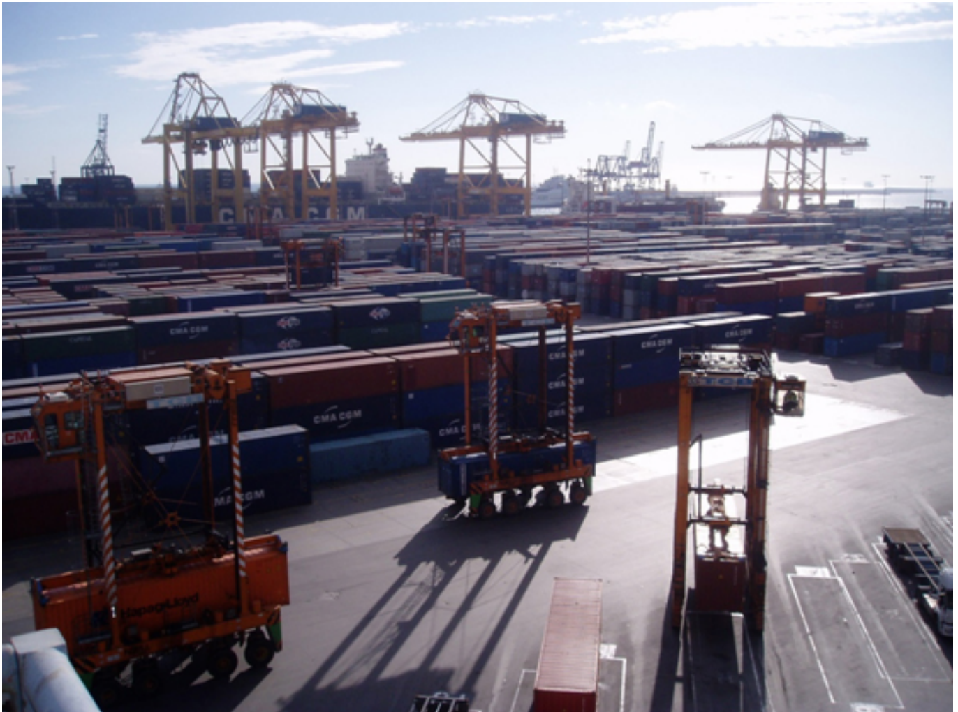
Puerto de Barcelona. Terminal de contenedores de TCB.
