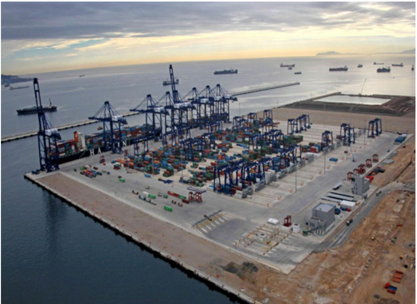
Puerto Bahía de Algeciras. Terminal de contenedores semiautomatizada. Total terminal internacional.
