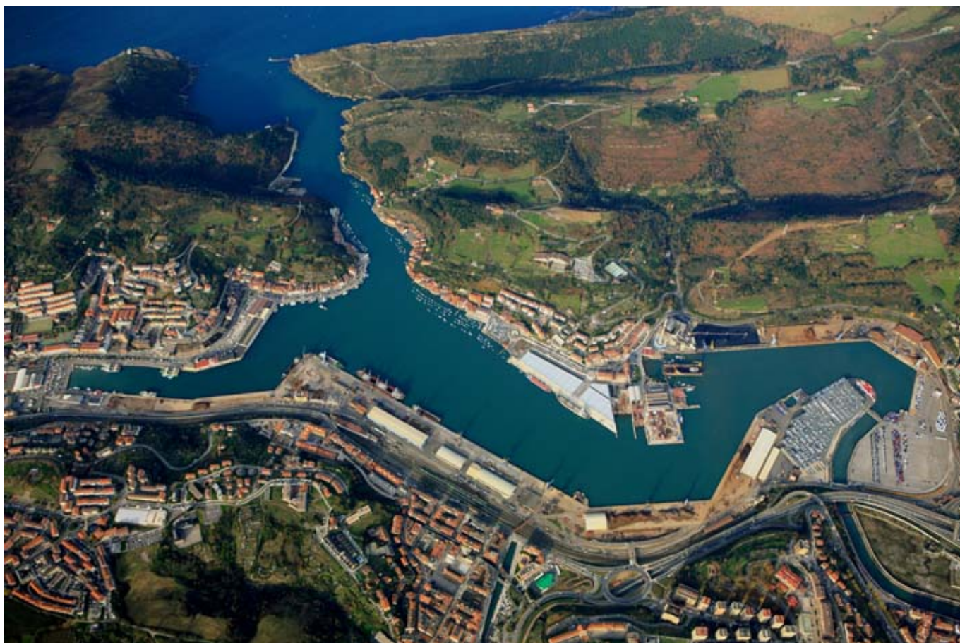
Puerto de Pasaia. Vista general. Fuente: Autoridad Portuaria de Pasaia.
