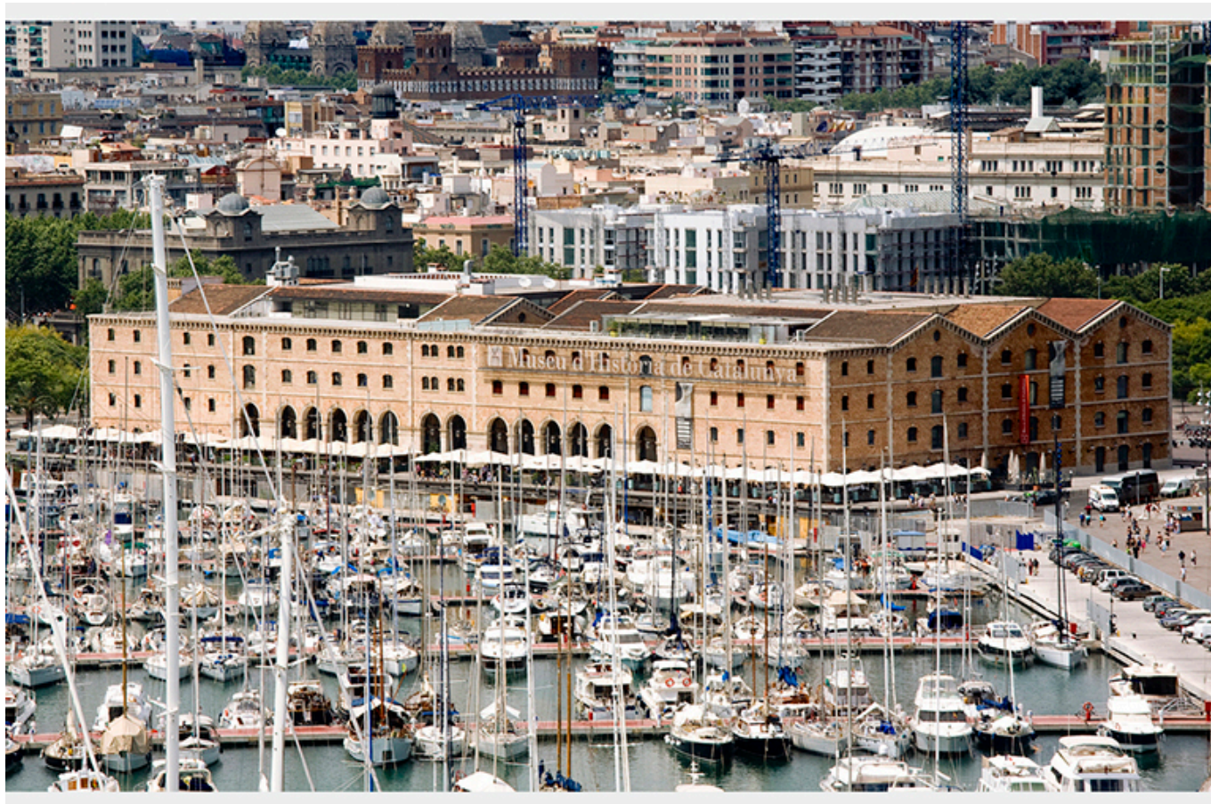
Puerto de Barcelona. Port Vell. Dársena deportiva Marina 92 y Almacenes Generales de Comercio. (Fuente: APB)
