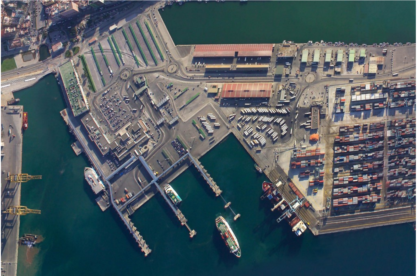
Puerto Bahía de Algeciras. Terminal de pasajeros y ferrys. (Fuente: APBA)
