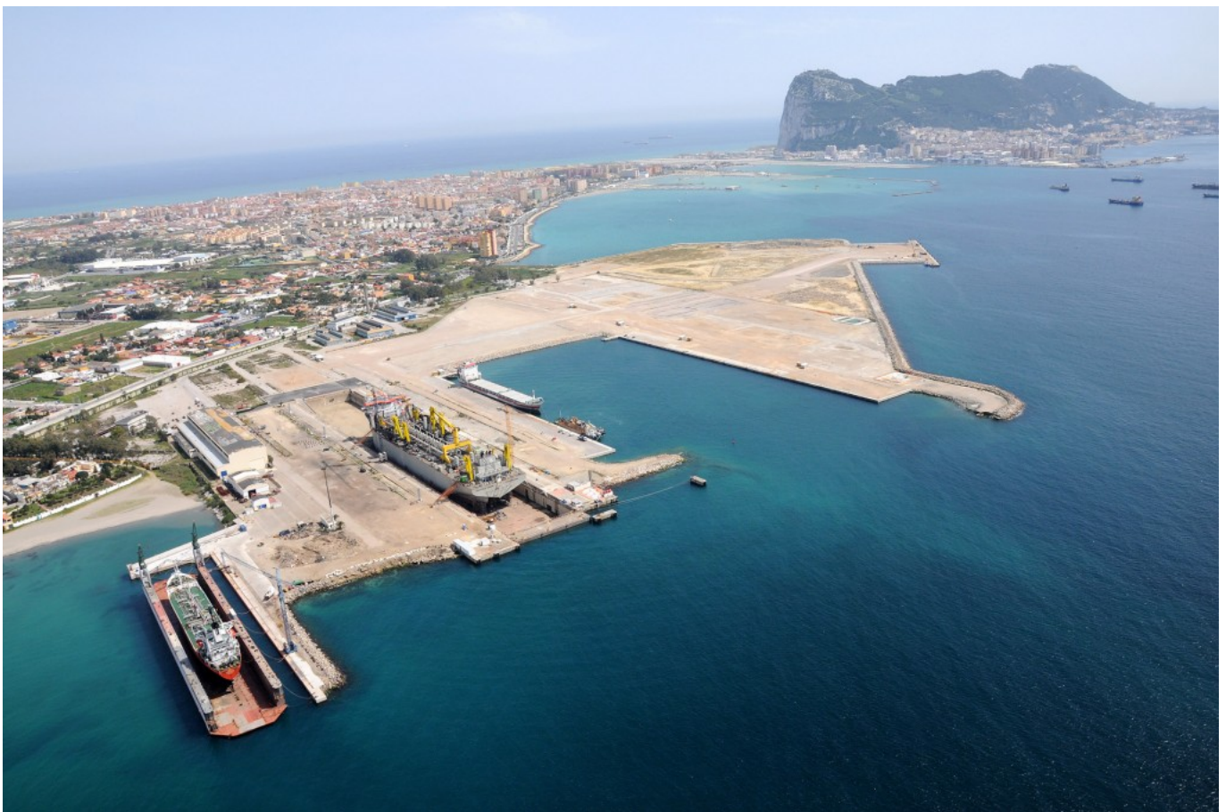
Puerto Bahía de Algeciras. Dársena de Campamento. Diques seco y flotante. (Fuente: APBA)
