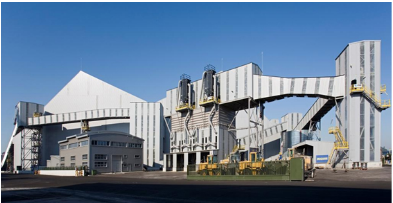
Noautum Ports. Terminal de graneles sólidos minerales, totalmente cubierta y automatizada. Autoridad Portuaria de Santander. ( Pedro Cantrero, 2007. Helicie Aviación, 2008)
