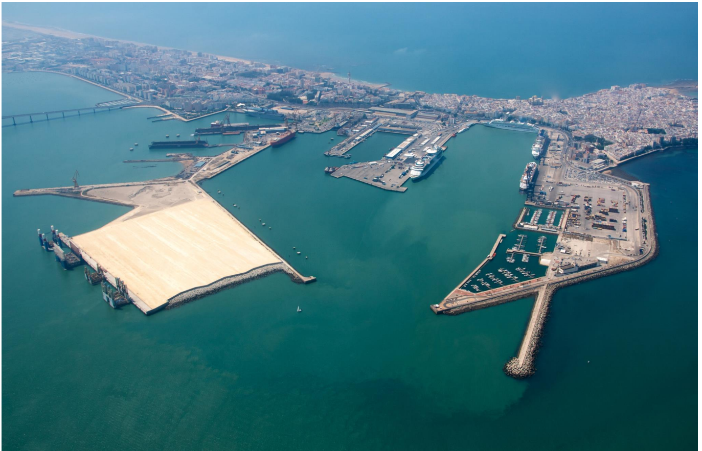
Vista panorámica del Puerto de la Bahía de Cádiz con la Nueva Terminal de Contenedores a la izquierda de la imagen. (© Autoridad Portuaria de la Bahía de Cádiz)
