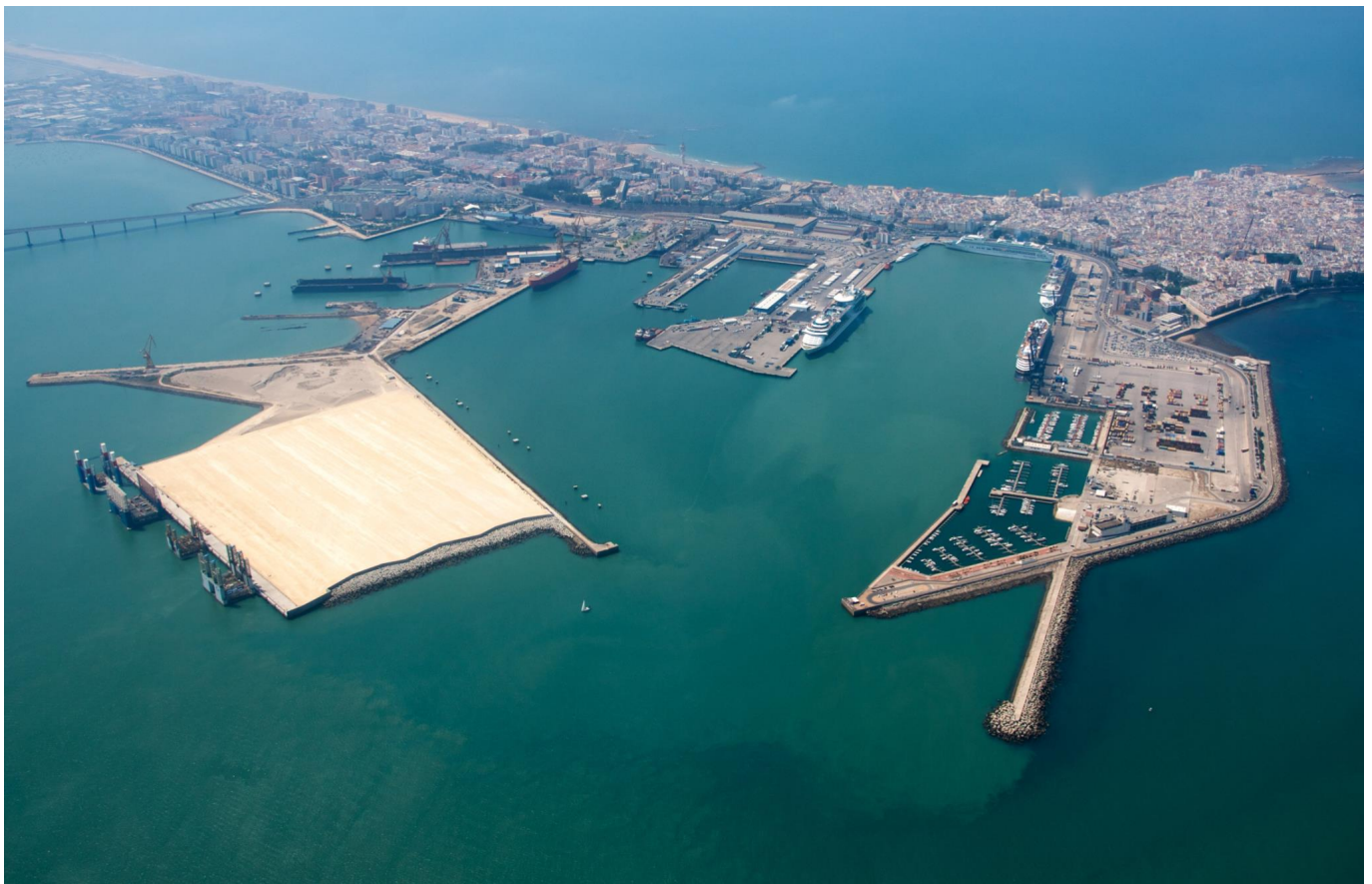
Vista panorámica del Puerto de la Bahía de Cádiz con la Nueva Terminal de Contenedores a la izquierda de la imagen. (© Autoridad Portuaria de la Bahía de Cádiz)
