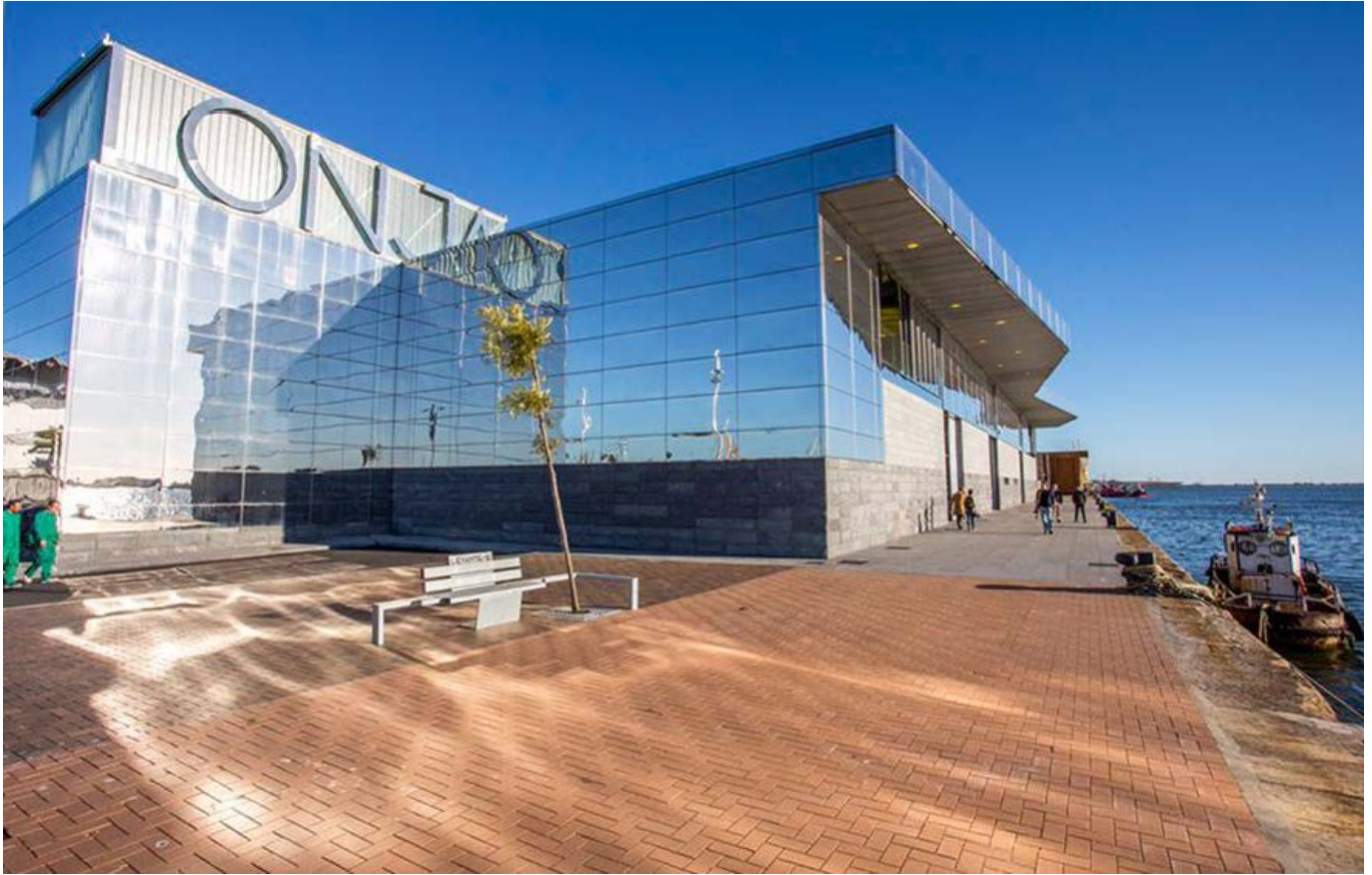
Nueva lonja de pescado y marisco del Puerto de Huelva. (Autoridad Portuaria de Huelva, 2021).
