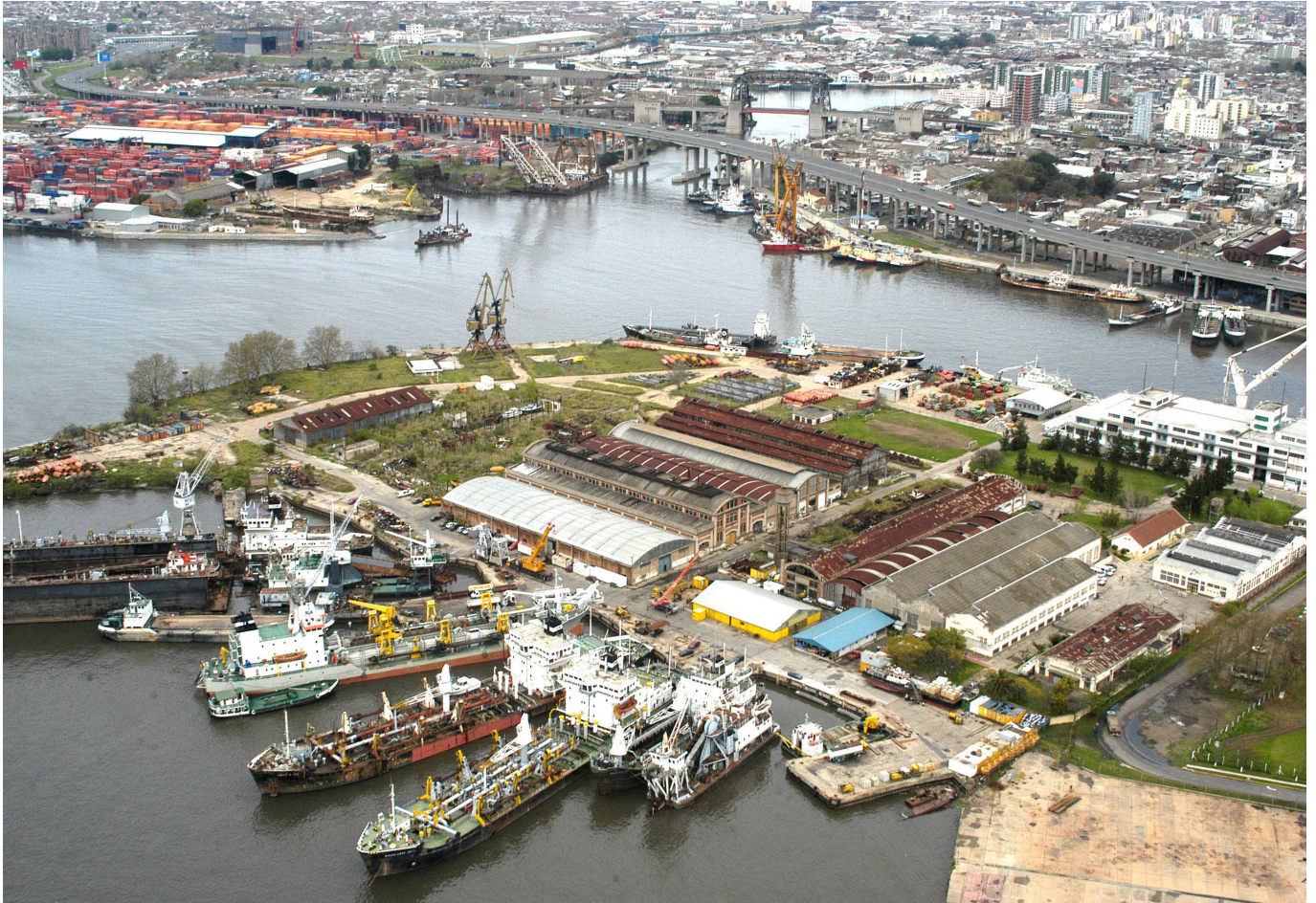
Sector Sur del Puerto de Buenos Aires.
