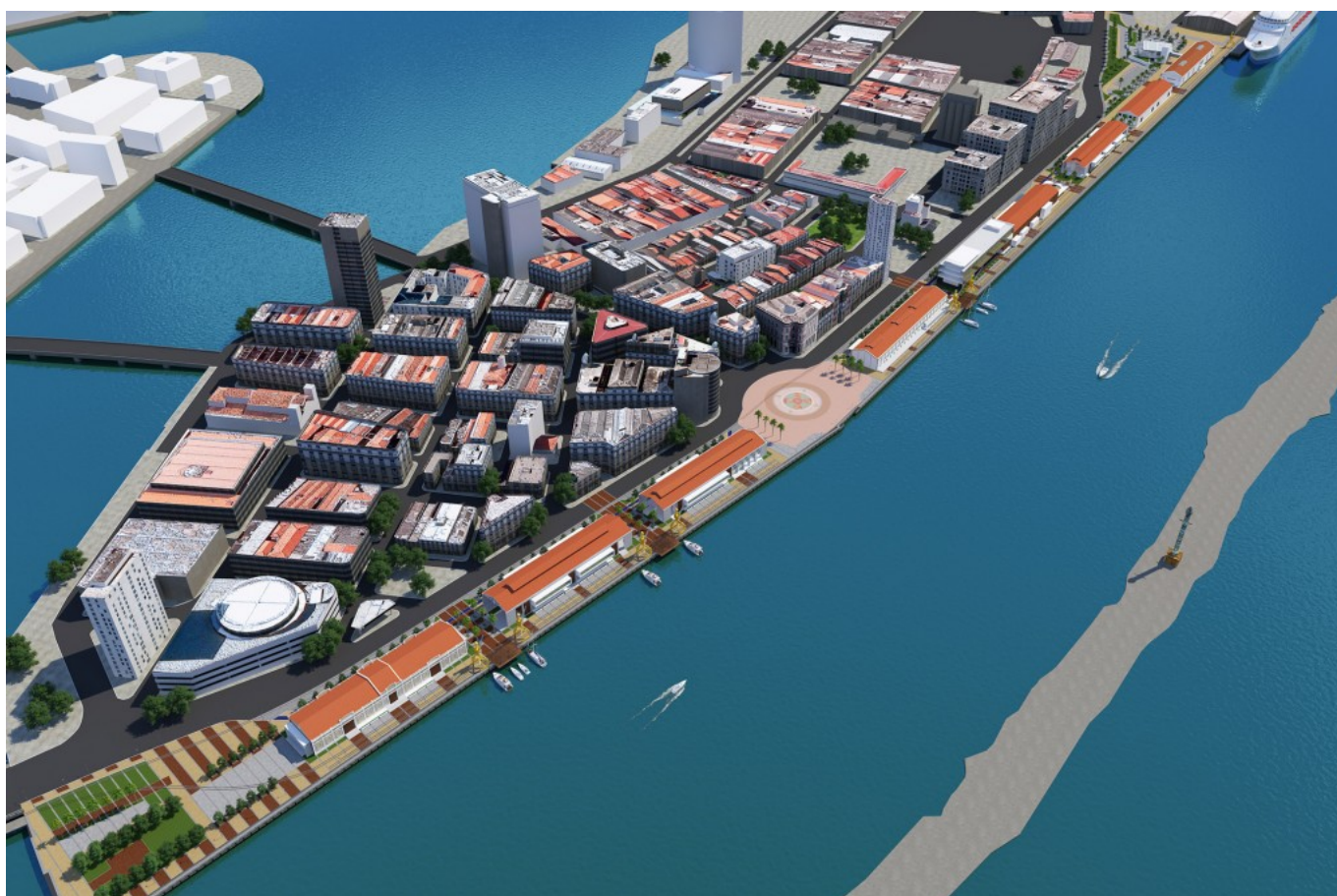
Vista general da intervenção.
