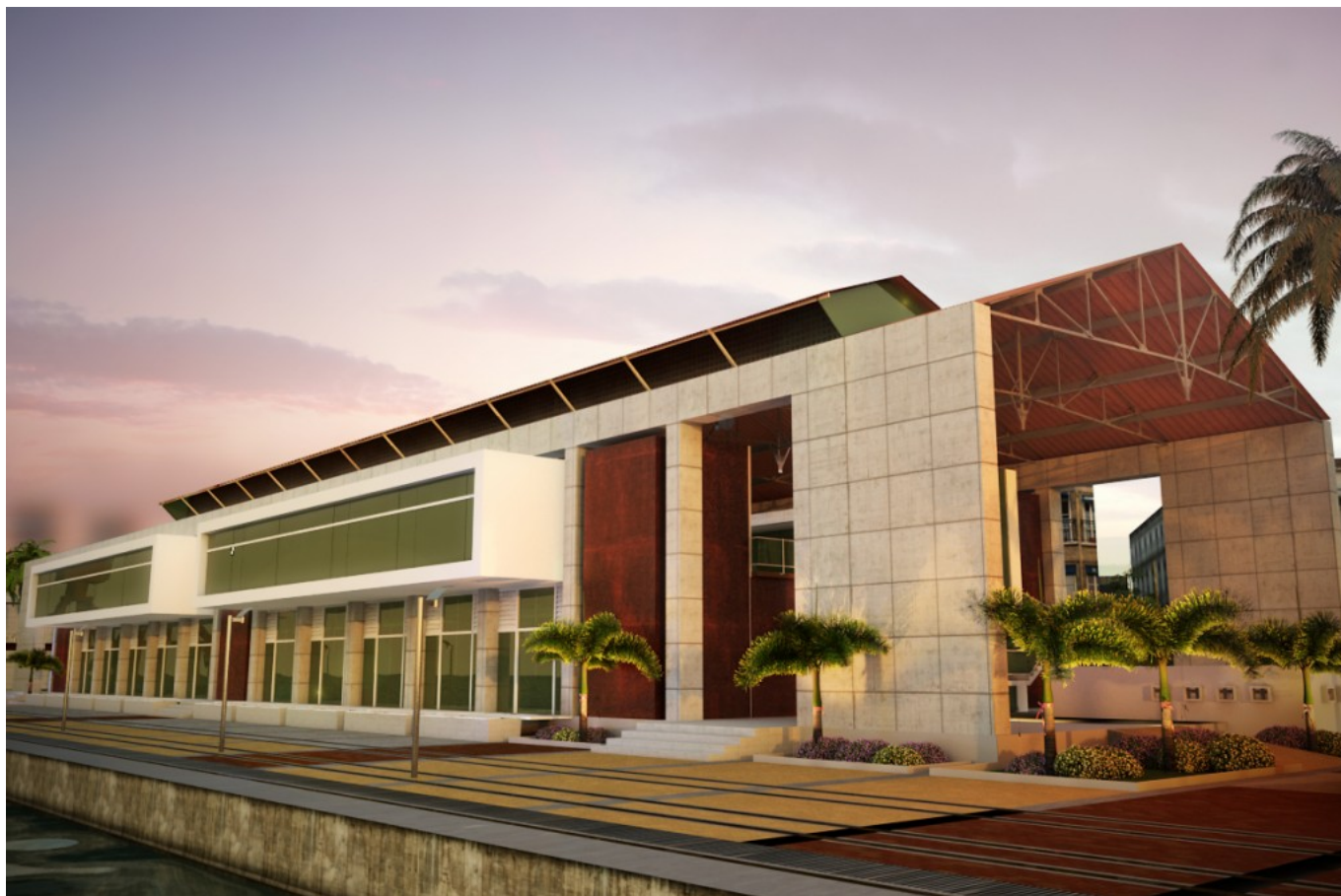
Vista externa do armazém 13.
