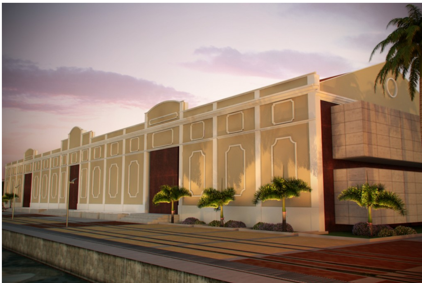
Vista externa do armazém 14.
