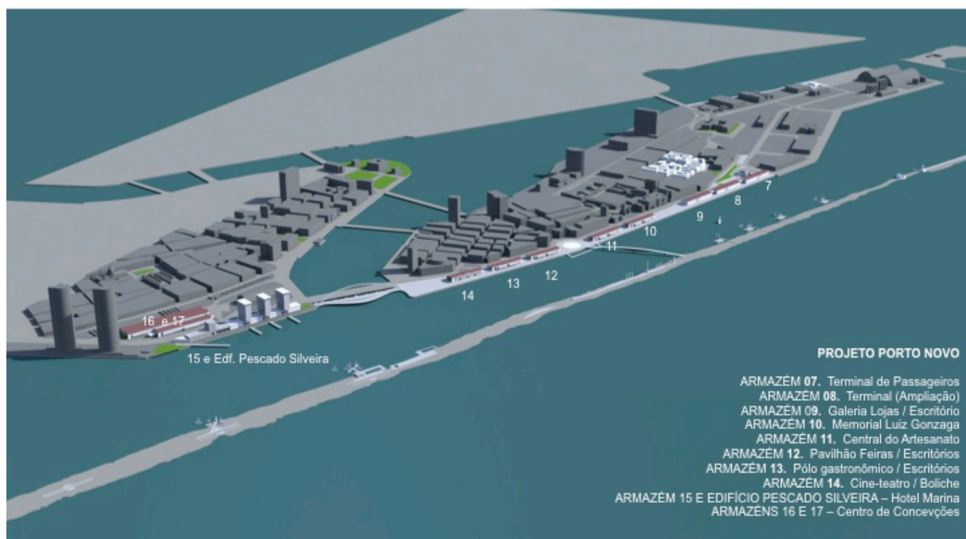
Vista general da intervenção.
