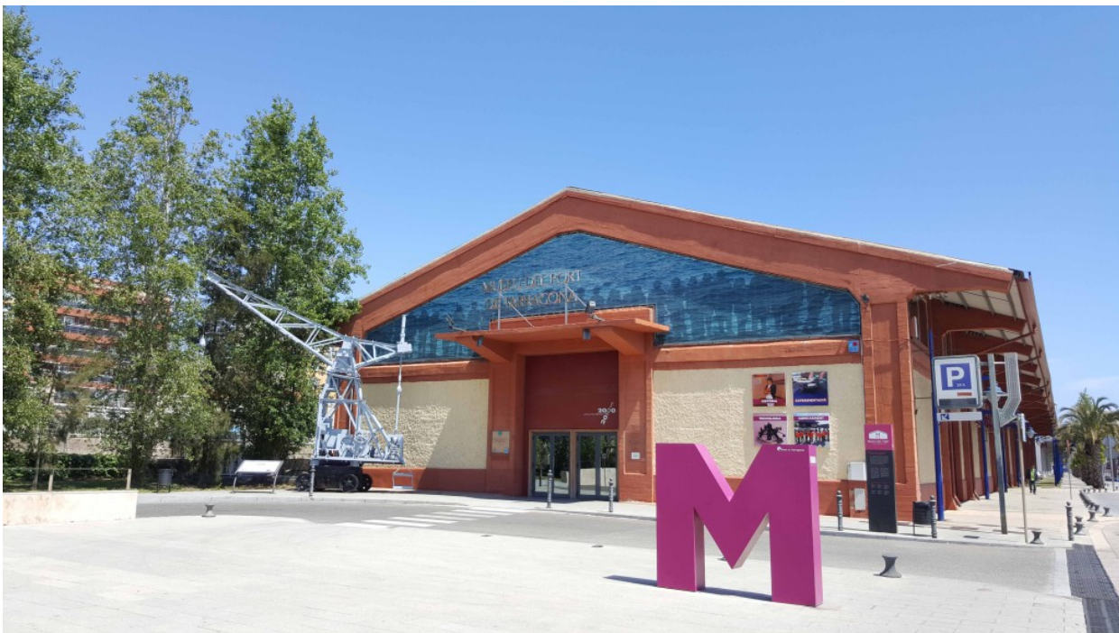
Vista exterior del Museu de Port en el almacén refugio mercancías del Moll de Costa.
