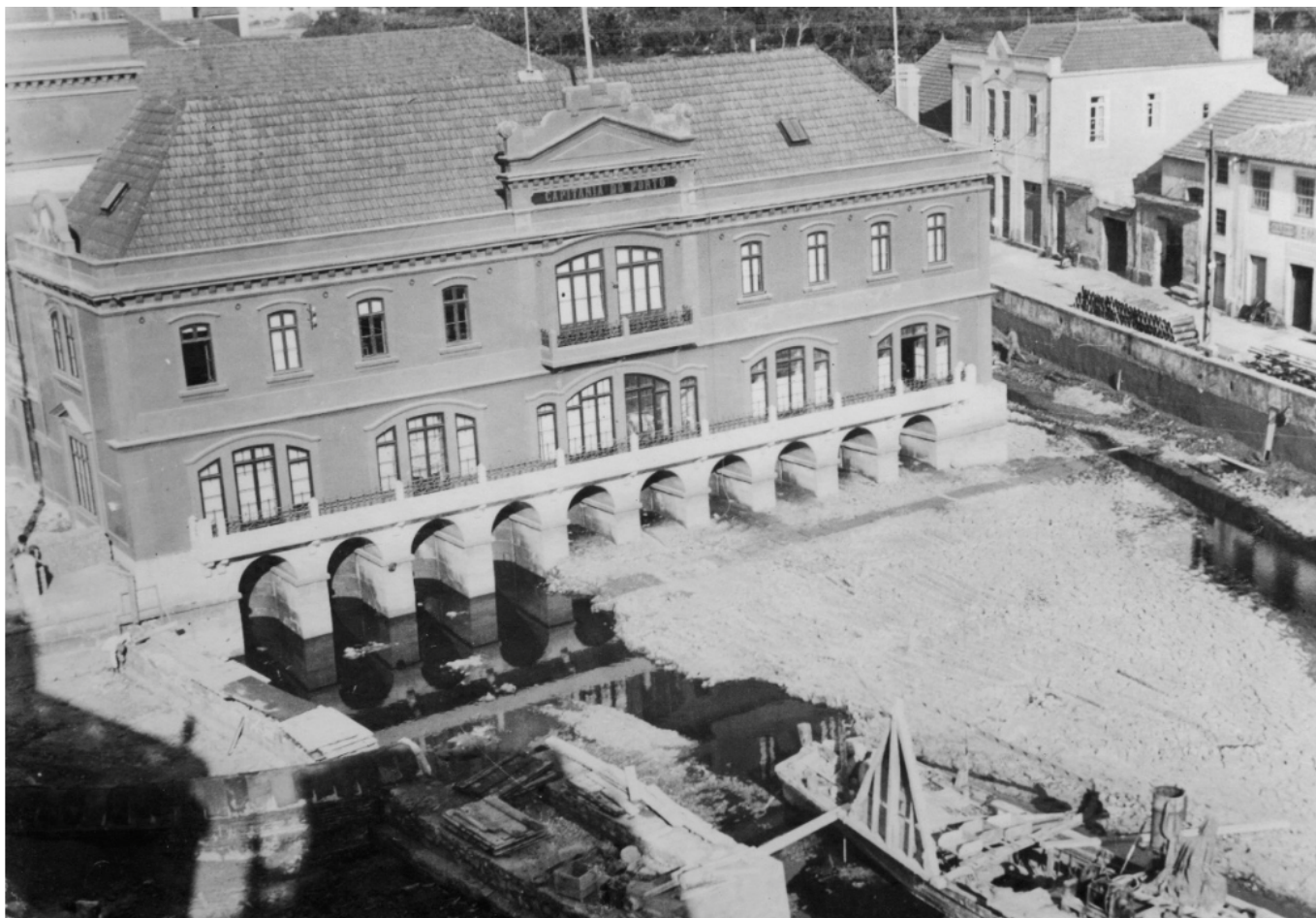
Construção do cais junto à Capitania do Porto de Aveiro em 1958. (Fonte: Imagoteca municipal, 2012)
