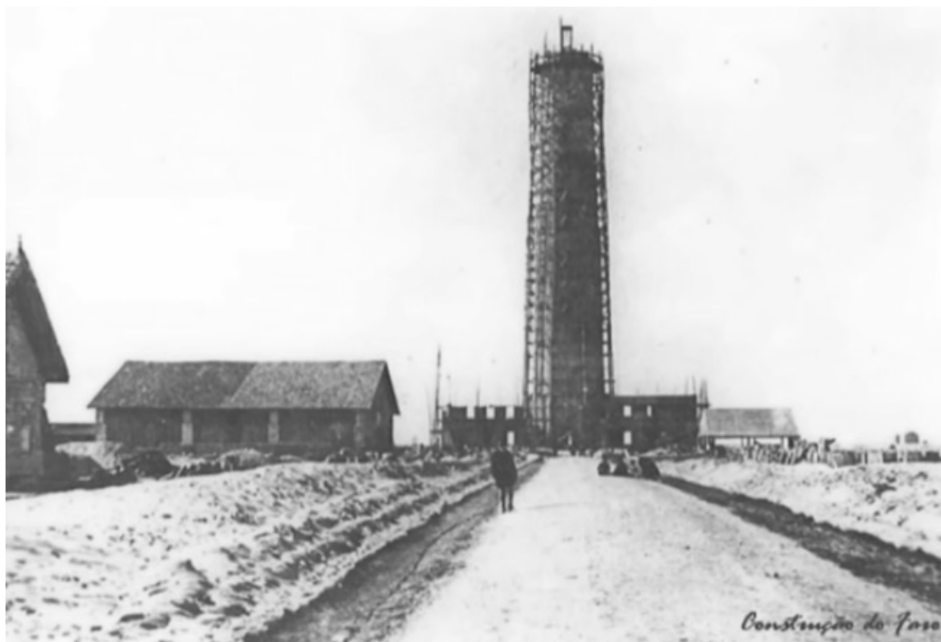
Construção do farol da Barra. (Fonte: APA, 2011)
