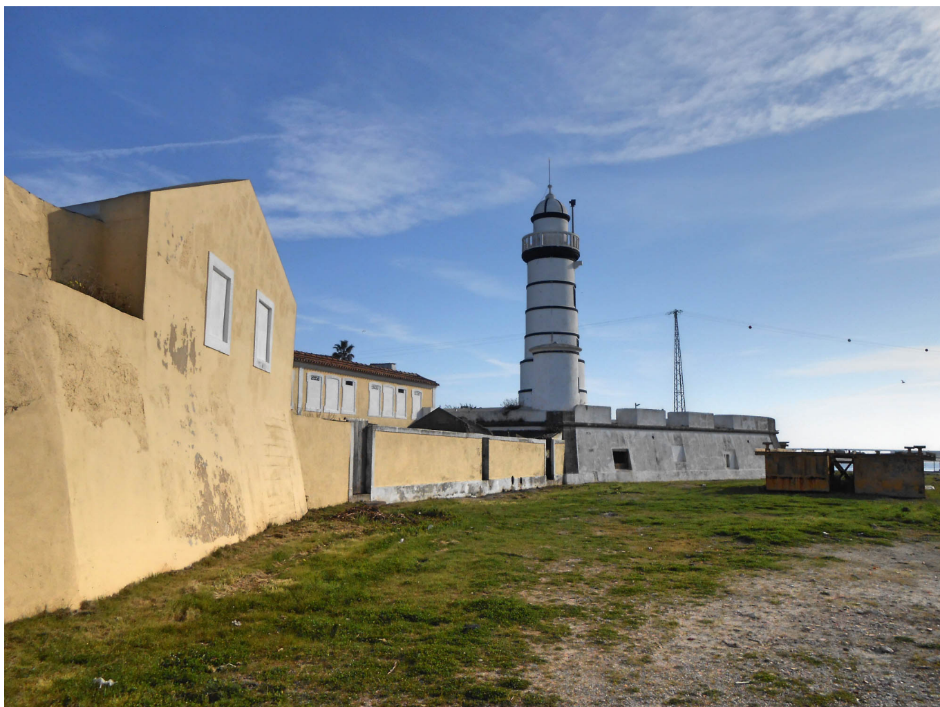
Estação de radio-telecomunicações do porto de Aveiro, século XXI. (Fonte: Lídia Matias, 2019)
