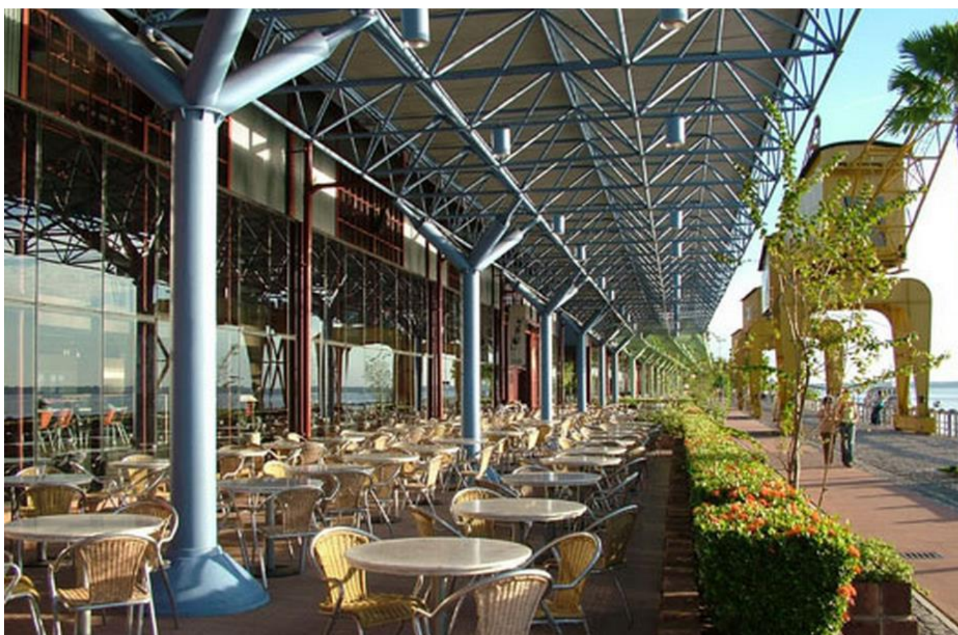
Estação das Docas - Belém/PA.
