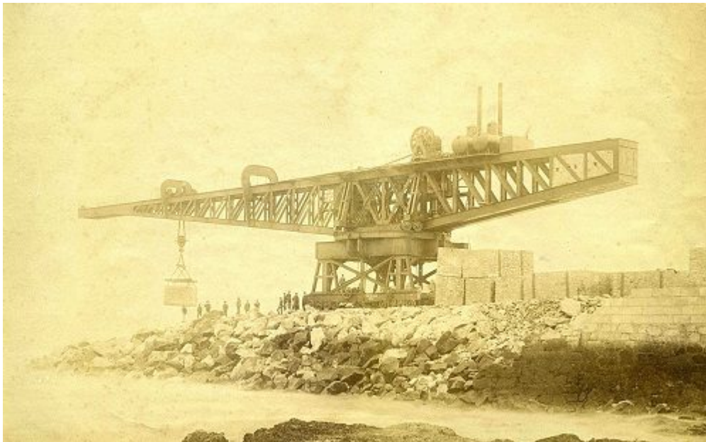
Início da construção do porto de Leixões - 1884.
