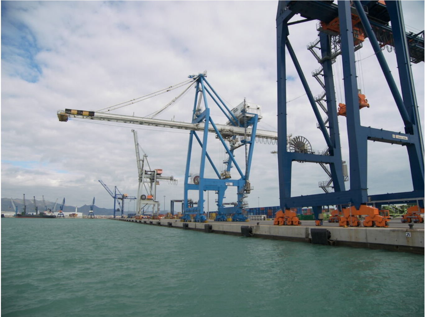
Muelles y grúas en el Puerto de Castellón. (Fuente: PortCastelló).
