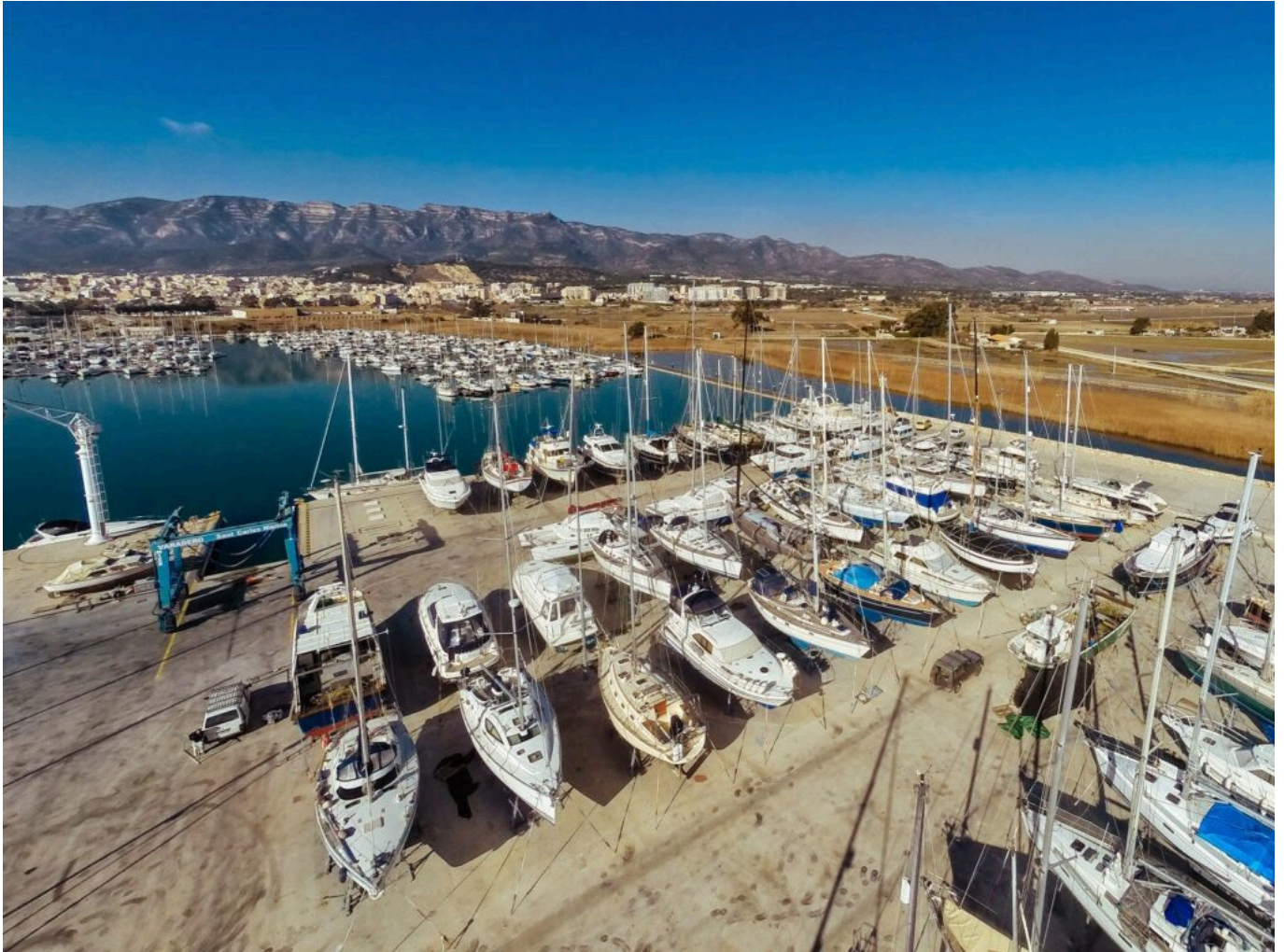
Sant Carles Marina, la instal·lació portuària de Catalunya situada en el límit del Parc Natural al sud del Delta del Ebro. (Fuente: Marina Sant Carles).
