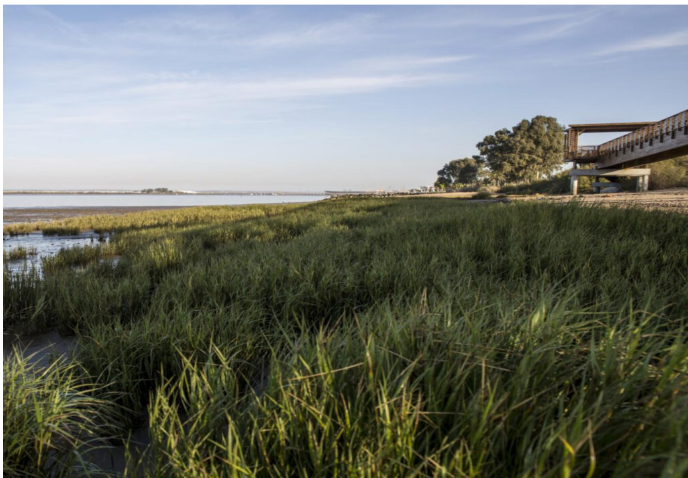
Recuperación ambiental de la margen izquierda de la ría del Odiel. (Fuente: Autoridad Portuaria de Huelva).
