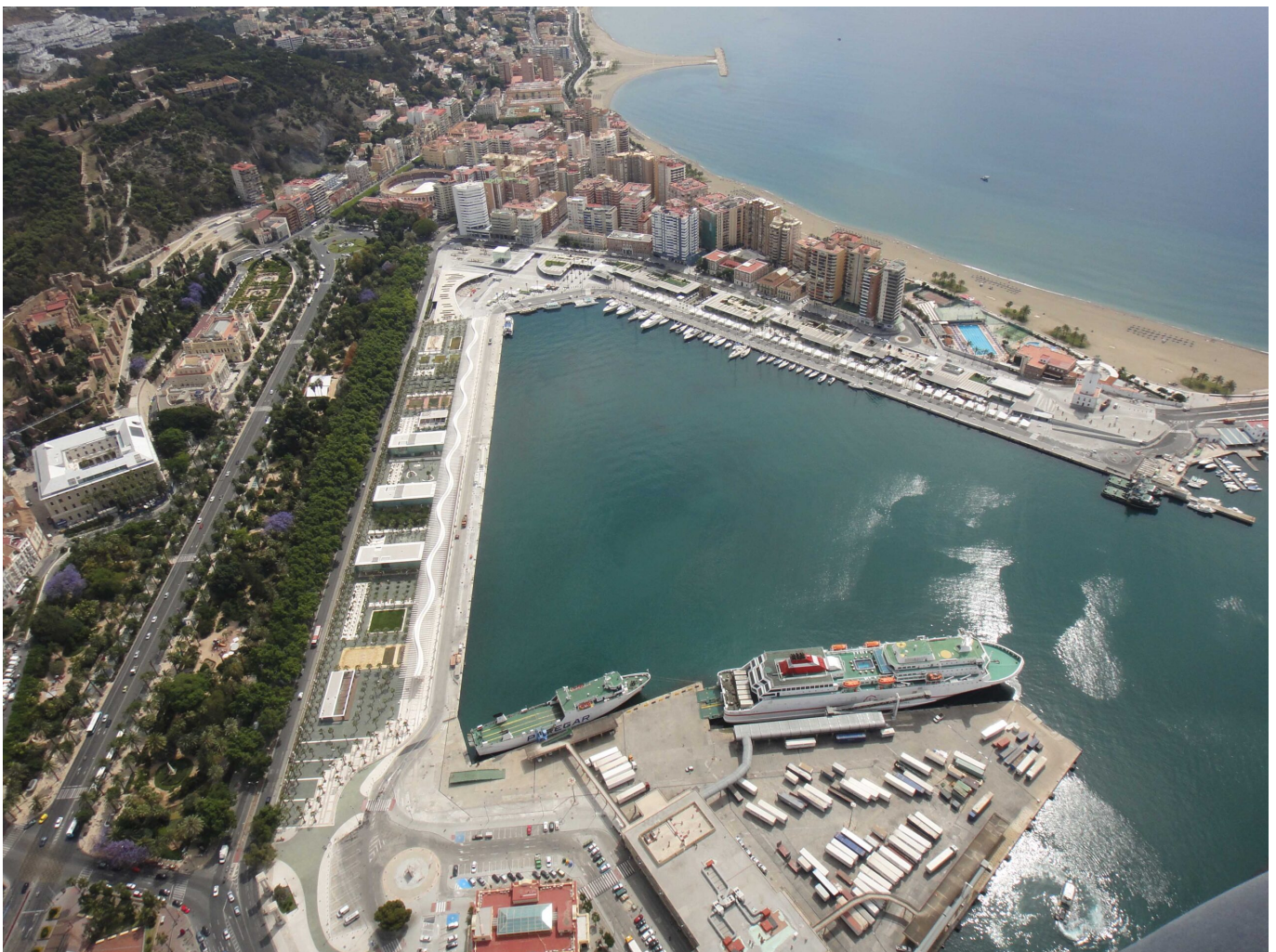
Vista de los muelles uno y dos tras la intervención. (Fuente: Autoridad Portuaria de Málaga).
