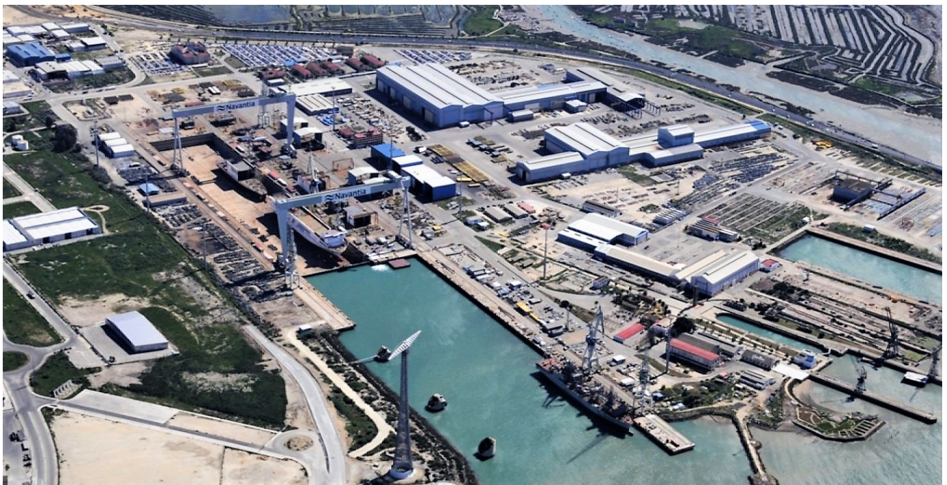
Vista aérea del Astillero de Puerto Real. (Fuente: Navantia)
