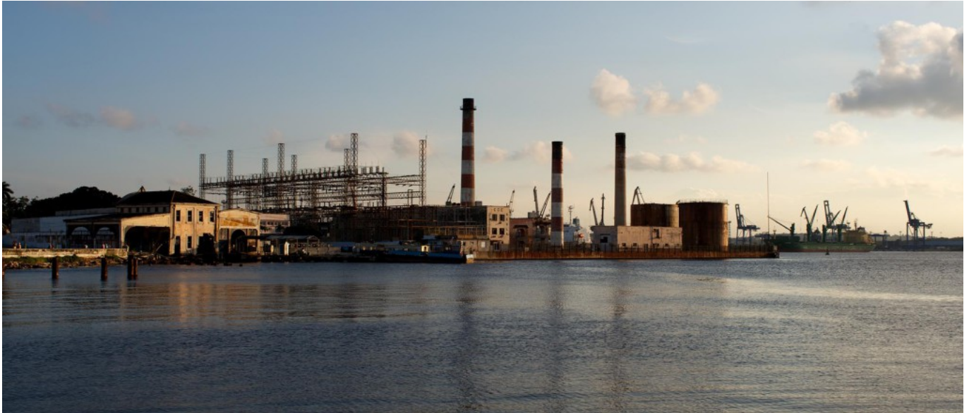
Central termoeléctrica Antonio Maceo en Regla, 2014.
