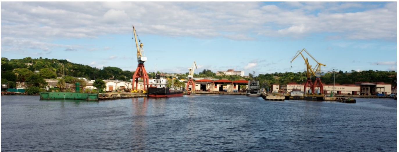
Instalaciones de reparación naval de Casa Blanca, 2015.
