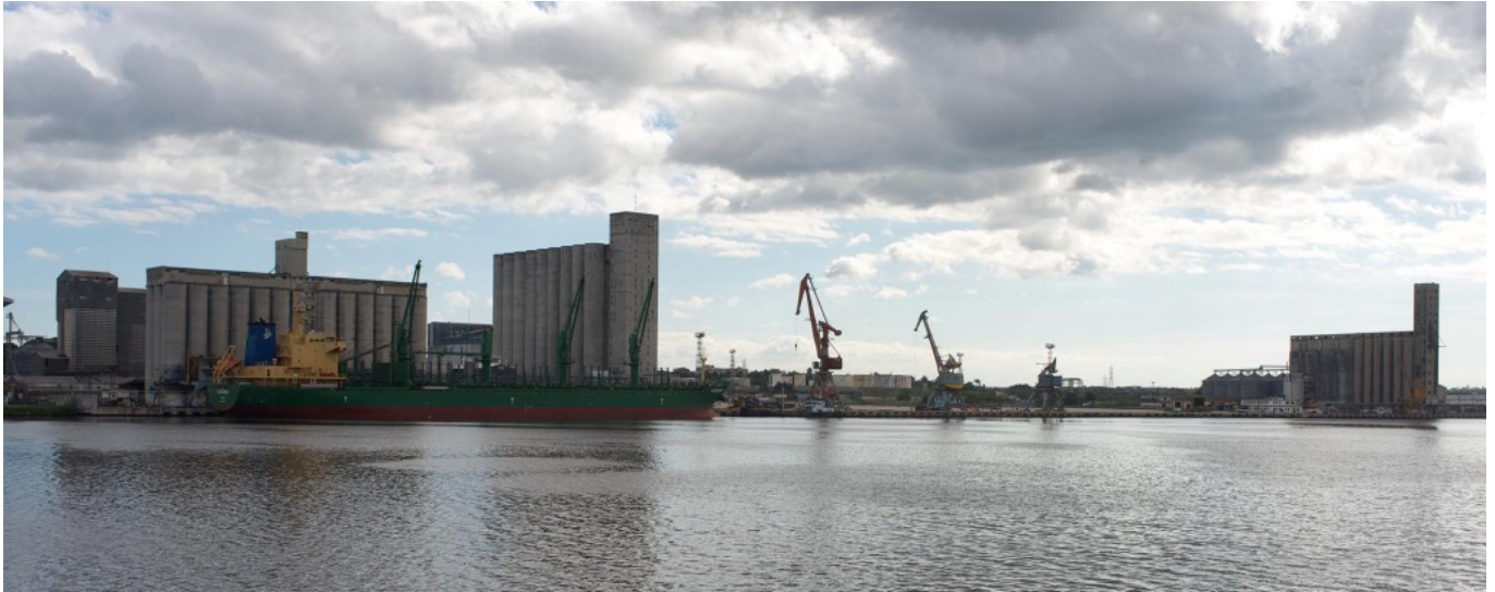
Silos y depósitos en ensenada Guasabacoa, 2014.
