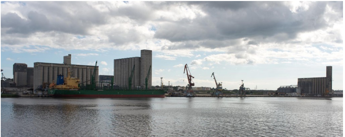
Silos y depósitos en ensenada Guasabacoa, 2014.
