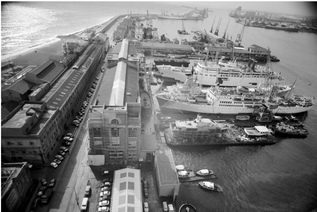
Actividad frente los dos edificios de Talleres Nuevo Vulcano, aproximadamente en 1970. (Fuente: Archivo del Museo Marítimo de Barcelona)
