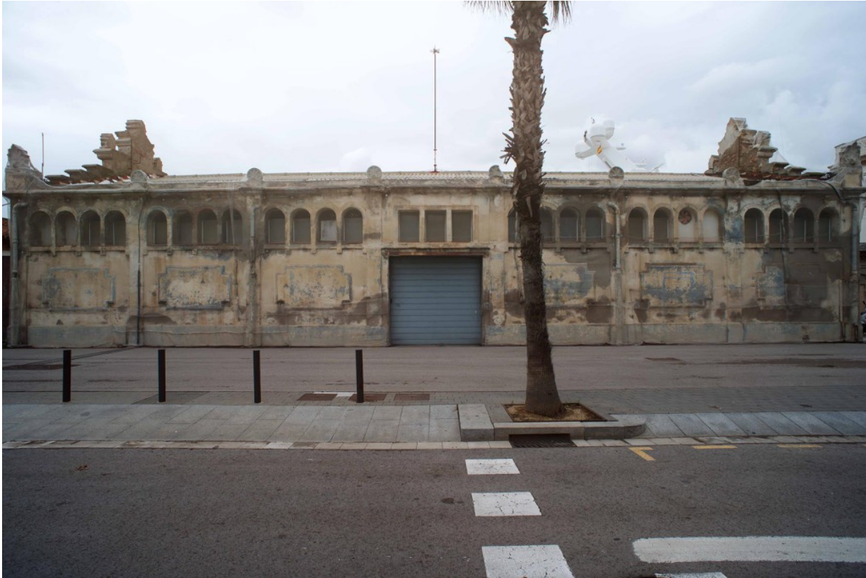
Edificio de la Carbonera en la actualidad (febrero de 2019). (Fotografía: © Joan Alemany)
