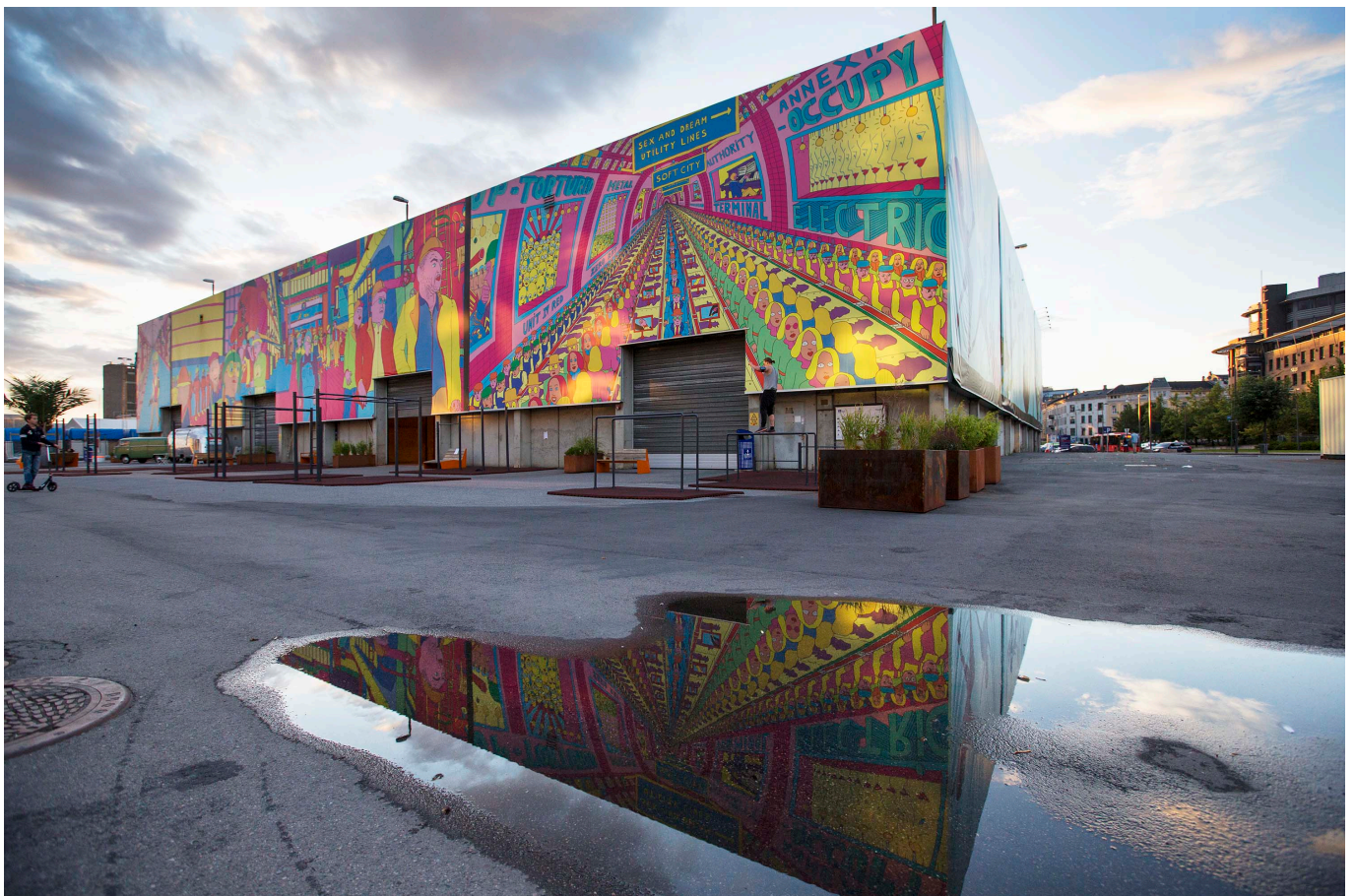
Skur 13 Fillipstadkaia. (@ Frode Sandbech)
