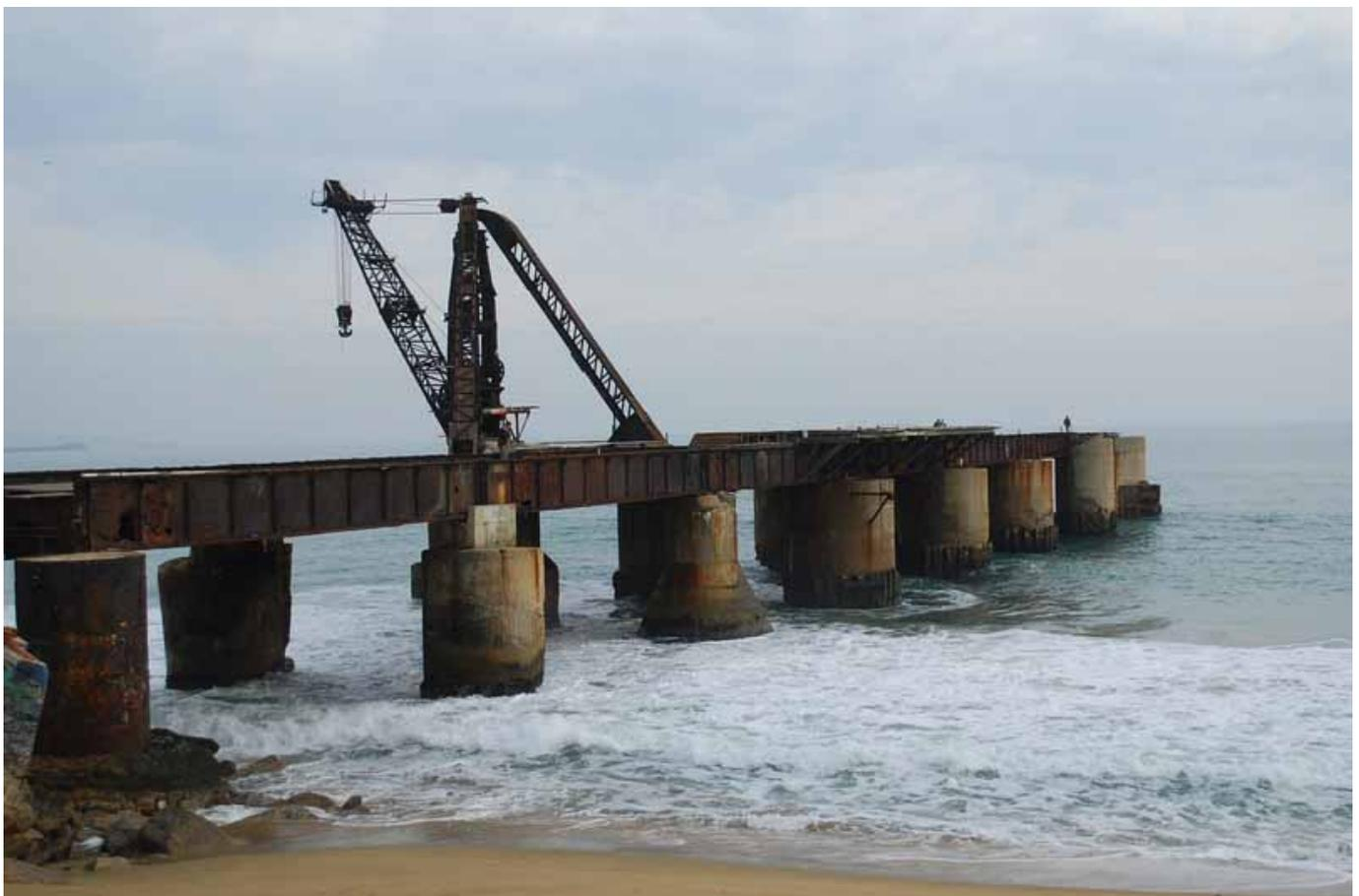
*Imagen del Muelle Vergara en estado de abandono y con riesgo de derrumbe, 2010.
