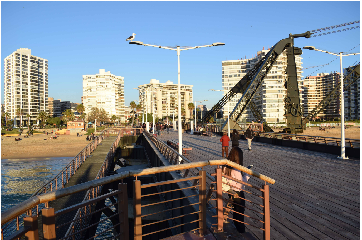
Muelle Vergara remodelado. Vista de la nueva plataforma central deck de madera, rampas a nuevos niveles de balcones y grúa restaurada, julio 2019. (Fuente: Marcos Moncada; equipo Diputado Andrés Celis)
