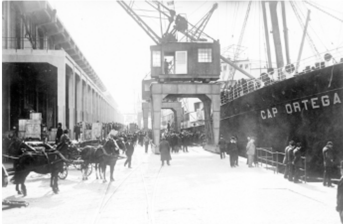
Muelle en operación abierto al público.
